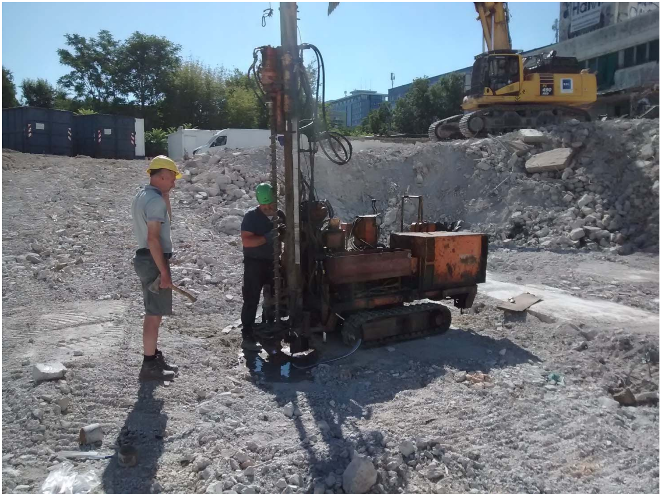
Titelfoto: Bohrarbeiten am 19.08.2025 auf dem Berolinastr. in 10178 Berlin-Mitte, Foto der BfU GmbH.
