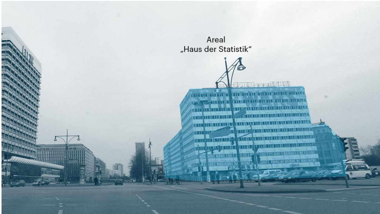
Abbildung 1: Blick auf das Areal "Haus der Statistik" - Blick von Karl-Marx-Allee in Richtung Norden
