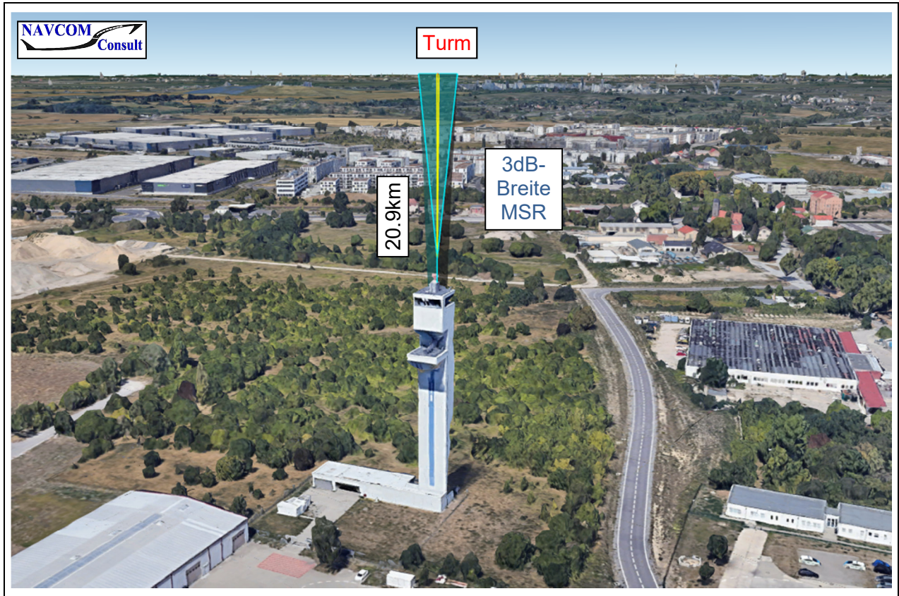
Bild 33: MSSR-N, 3dB-Breite in Radarhöhe; Turm, Blick auf das Baugebiet
