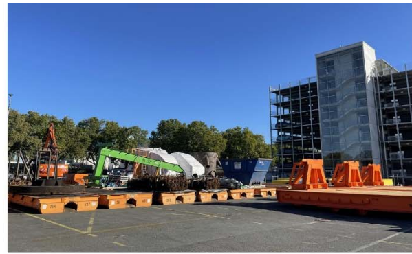
Abb. 5: Blick vom Parkplatz Richtung Nordosten auf das neu gebaute Parkhaus
