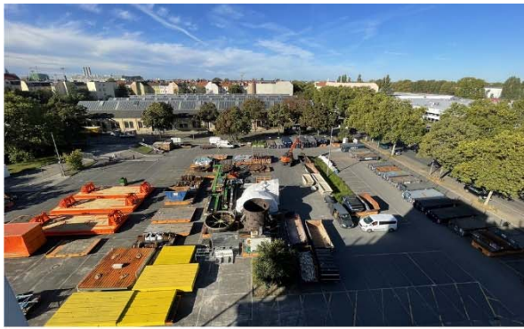
Abb. 4: Blick vom Parkhausdach Richtung Westen auf die zum Großteil versiegelte Parkplatzfläche mit angrenzender Straßenführung
