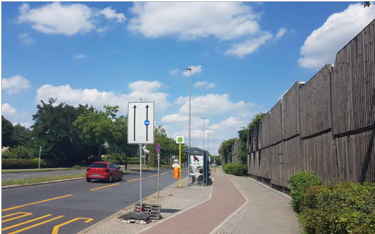
Abbildung 2-1 Lärmschutzwand östlich des Blumberger Damms | Blickrichtung nach Norden | eigene Aufnahme
