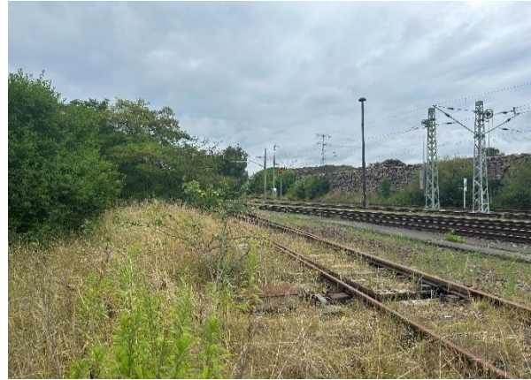
Abbildung 9: Gleisbereich in der Mitte der Beschattungsfläche
