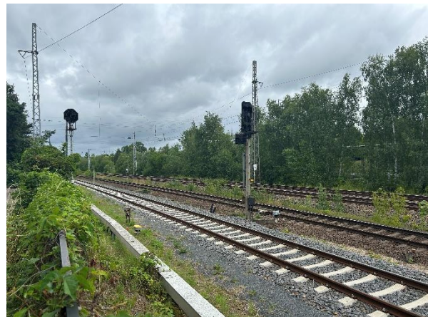
Abbildung 15: Nördlich der Brücke Gehrenseestraße (Blickrichtung Norden)
