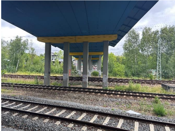
Abbildung 12: Nördlich außerhalb der Beschattung (Brücke Gehrenseestraße)
