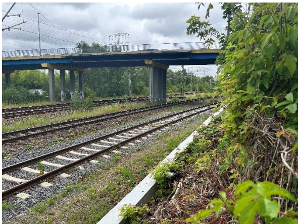
Abbildung 14: Nördlich der Brücke Gehrenseestraße
