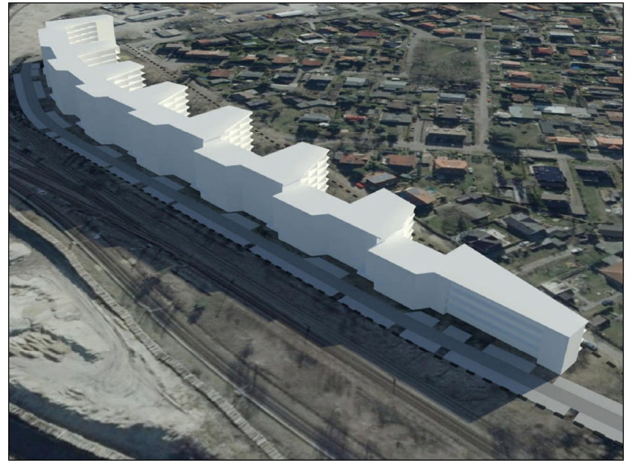
Ansicht von Norden
