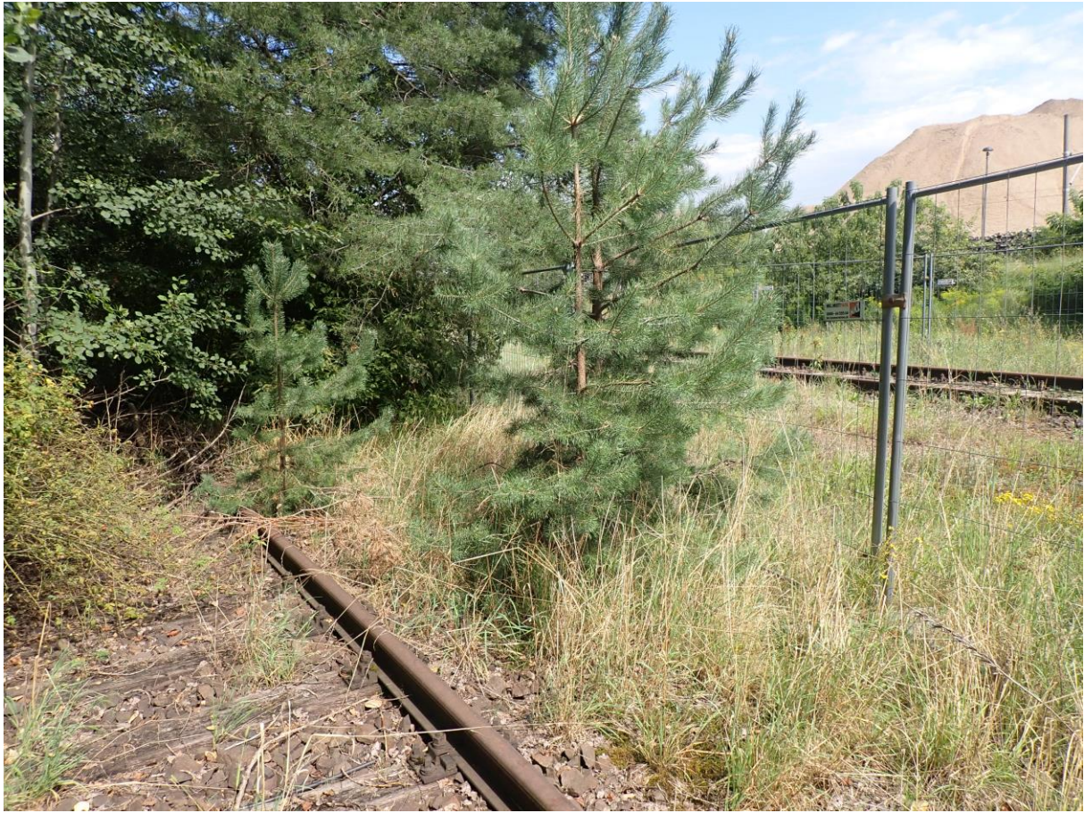
Abbildung 4: Alte Gleise mit spärlicher Vegetation (Foto 08/2023)
