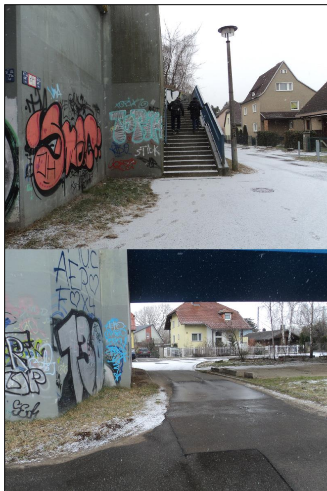
Abbildung 24: Unterführung Annimstraße – Detlevstraße / Treppenanlage
