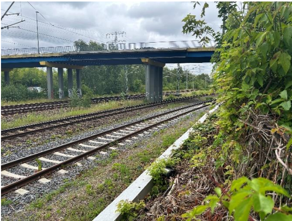
Abbildung 14: Nördlich der Brücke Gehrenseestraße
