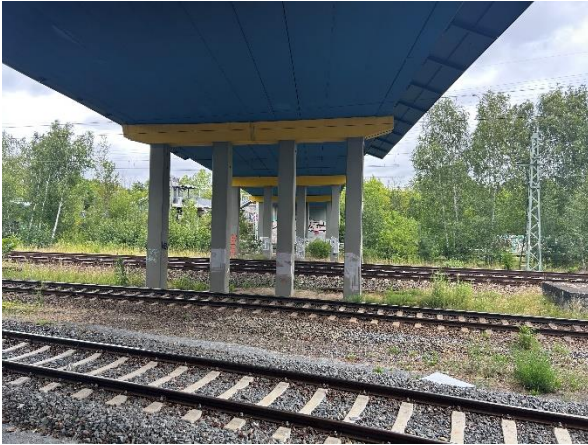
Abbildung 12: Nördlich außerhalb der Beschattung (Brücke Gehrenseestraße)
