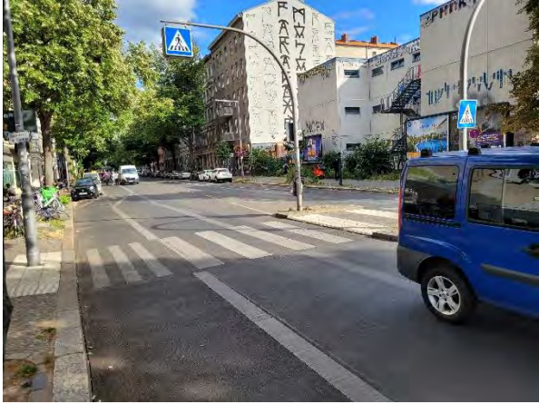
Abbildung 17: Wohngebäude Köpenicker Straße 183/Oberstufenzentrum Zeughofstraße 26 im Bild rechts oben (Osten)
