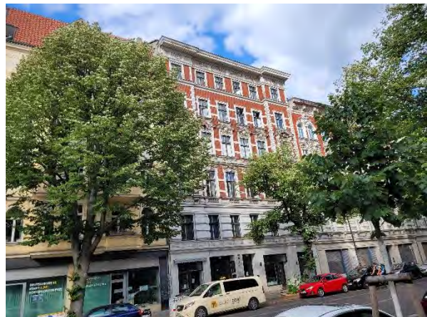
Abbildung 16: Wohngebäude Köpenicker Straße 10 (Norden)
