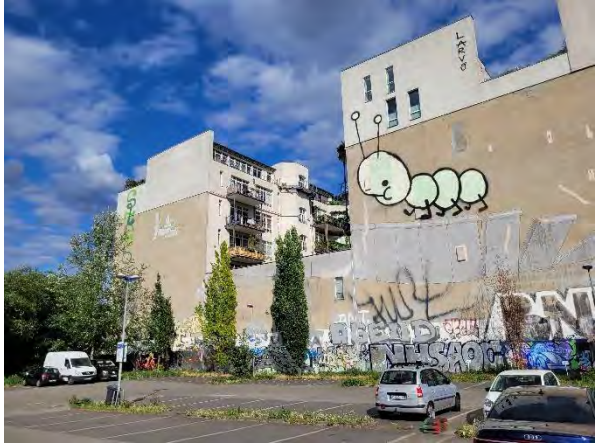
Abbildung 11: Wohngebäude Köpenicker Straße 10a (Nordosten)
