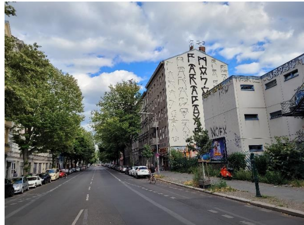
Abbildung 19: Köpenicker Straße südöstlich des Plangebiets (Osten)
