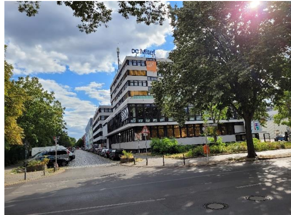
Abbildung 17: Zeughofstraße 1 / Büroflügel des Zeughofs (Süden)
