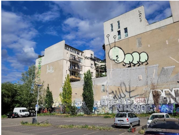
Abbildung 10: Wohngebäude Köpenicker Straße 10a (Nordosten)
