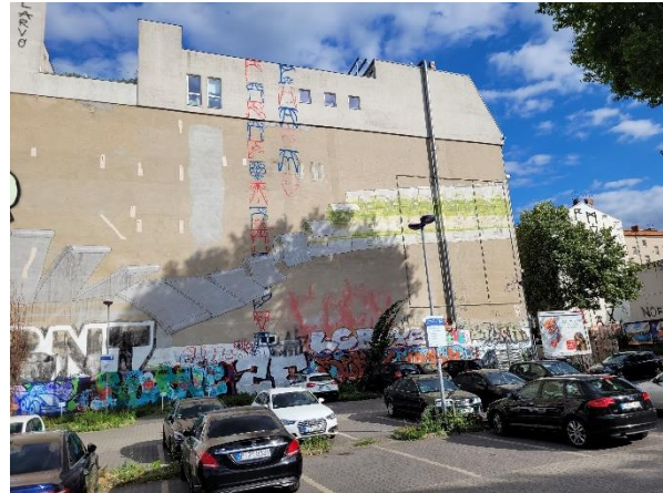
Abbildung 11: Wohngebäude Köpenicker Straße 10a (Osten)
