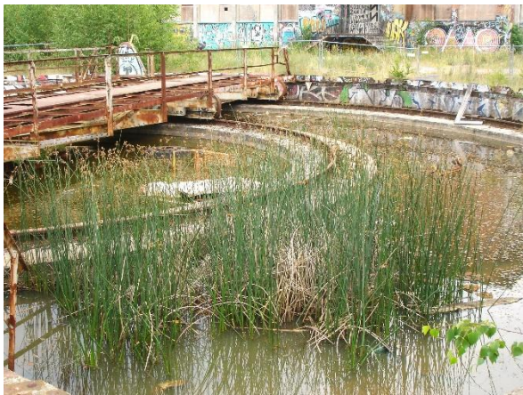
Abbildung 16: Kleingewässer im Becken der Drehscheibe des Ringlokschuppens, mit Teichsimsen-Röhrlicht und Laichkrautdecke (Abschnitt 4, Biotop 323, Blickrichtung Nordwest)
