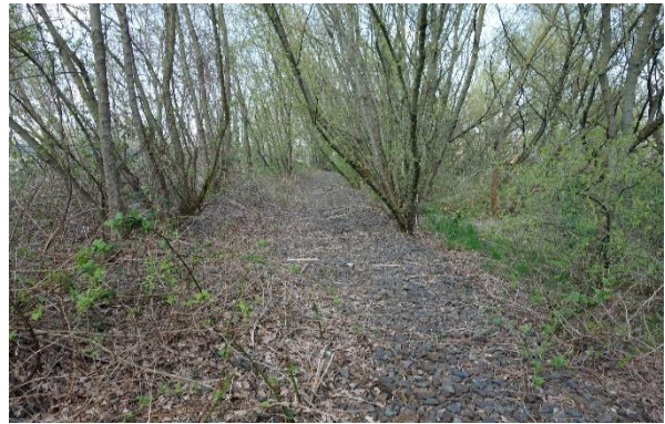
Abbildung 8: Ehemalige Gleistrasse (Schotterbett)
