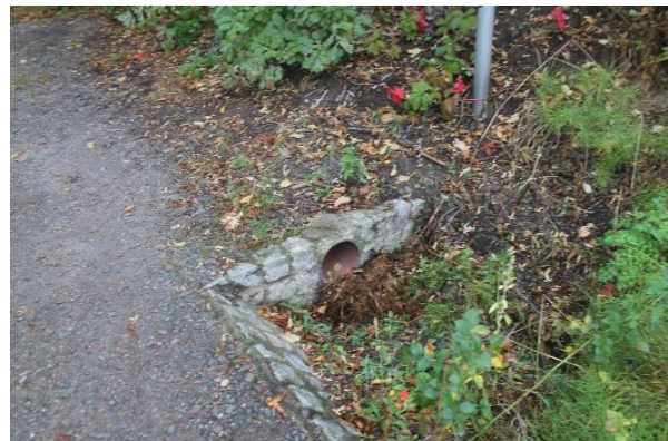
Abbildung 14: Bestehende Verrohrung am Heimdallgraben
