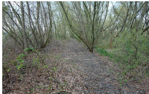
Abbildung 7: Ehemalige Gleistrasse (Schotterbett)
