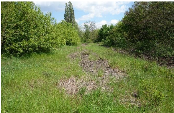
Abbildung 6: Ehemalige Gleistrasse (Schotterbett)
