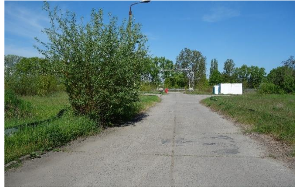
Abbildung 3: Betonflächen und -wege
