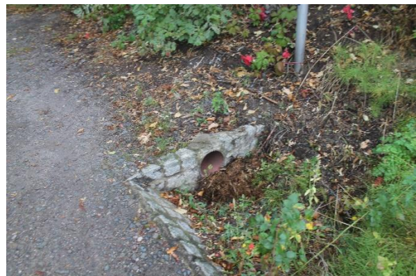
Abbildung 13: Bestehende Verrohrung am Heimdallgraben
