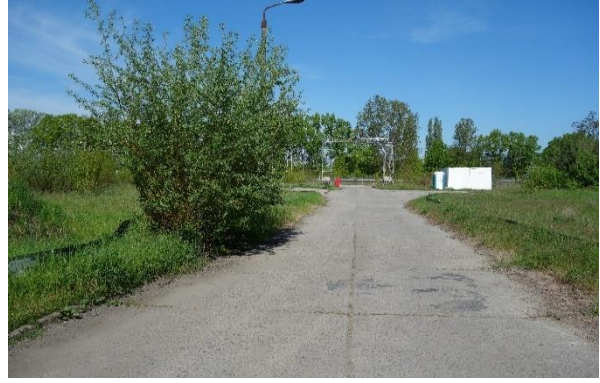
Abbildung 4: Betonflächen und -wege
