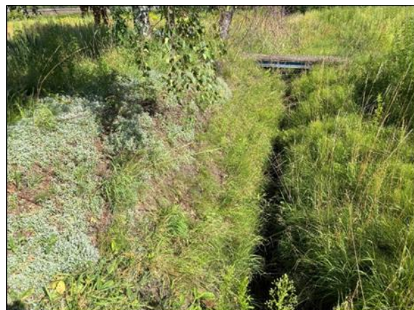
Abbildung 2: Heimdallgraben-Abschnitt mit geringer Einschnittstiefe
