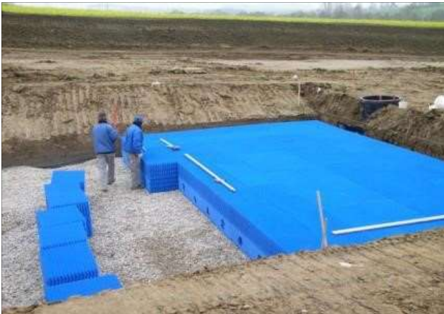
Abbildung 15: Bau einer Füllkörperrigole (Sieker)
