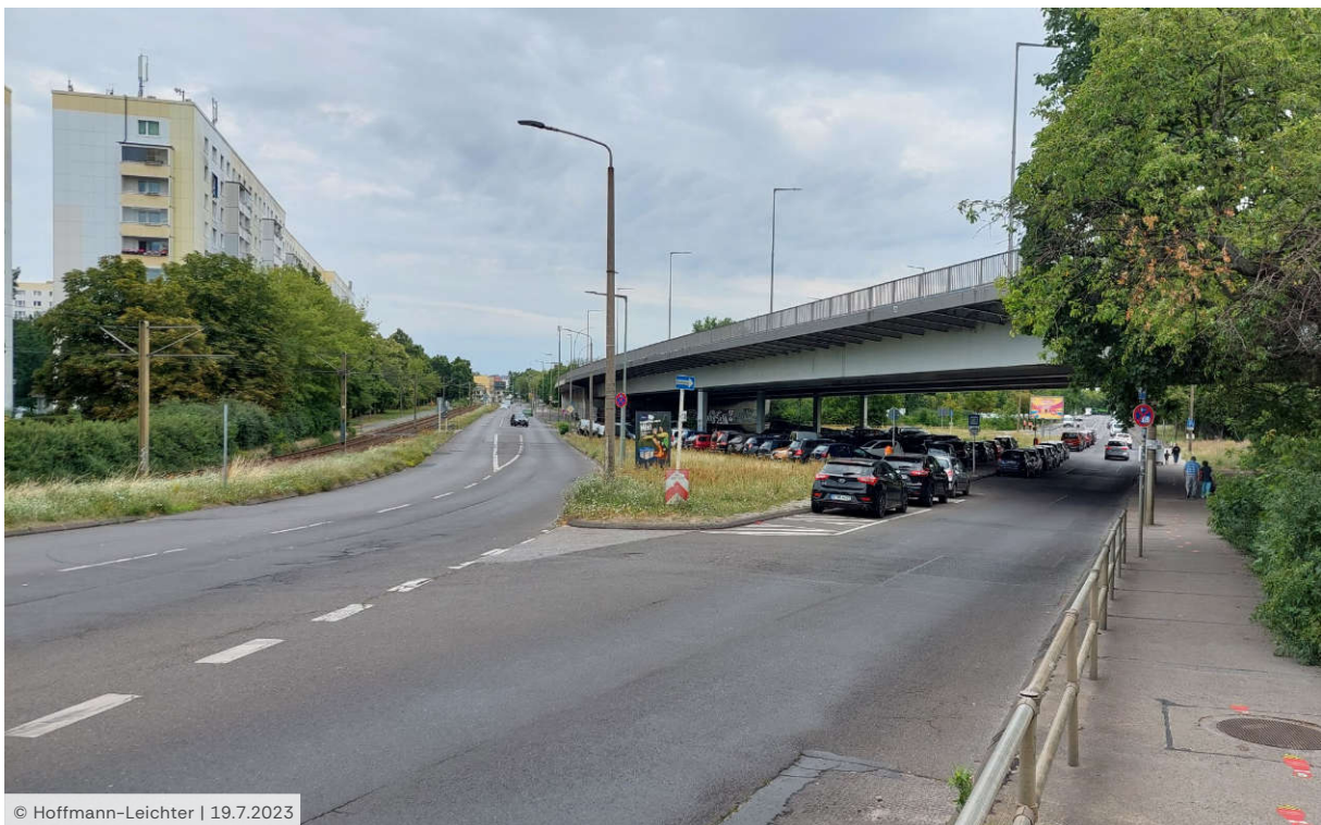
Bild 22 Unterführung Pasewalker Str. | Blickrichtung Nordost
