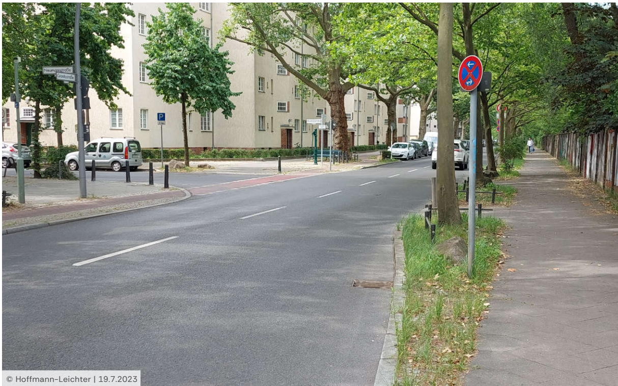
Bild 6 QS Granitzstr. Höhe Neumannstr. | Blickrichtung Südwest
