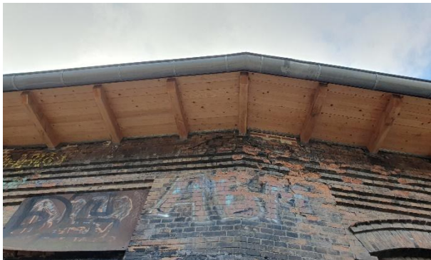
Abbildung 51: Neu ausgebauter Dachbereich
