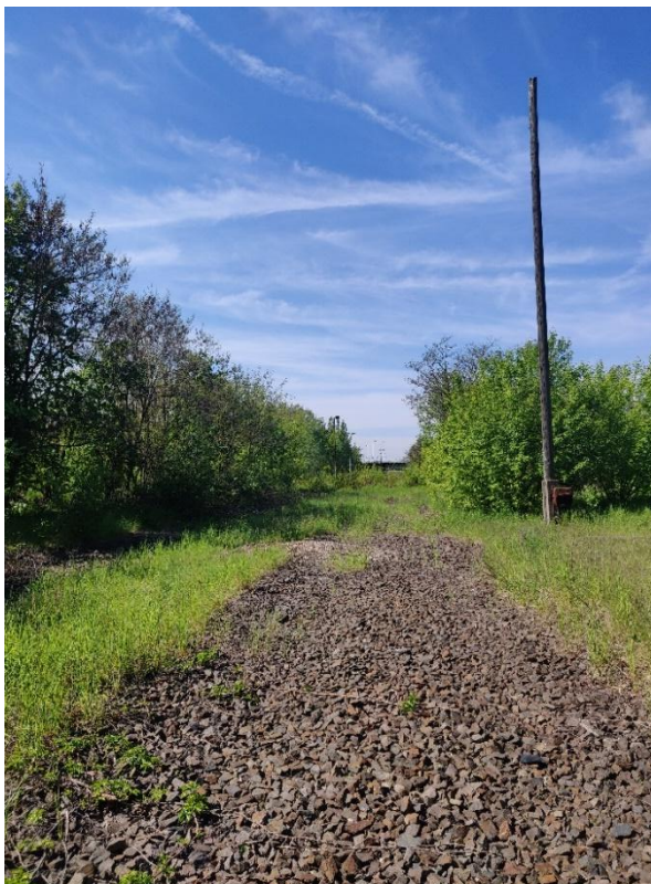
Abbildung 151: Aufgelassene Gleisanlagen auf PT03_TF01 am 11.5.2023 (Blickrichtung NO-SW)
