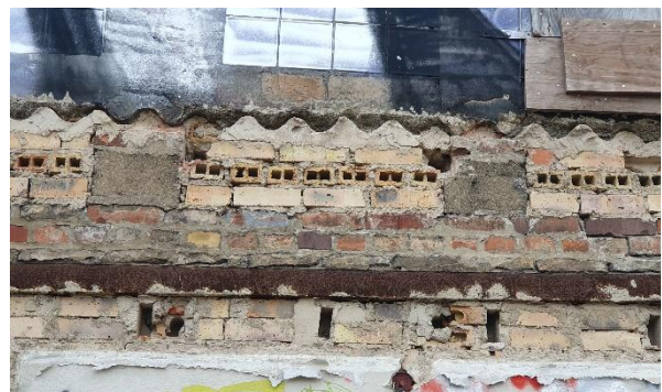
Abbildung 46: Hohlblocksteine im Mauerwerk
