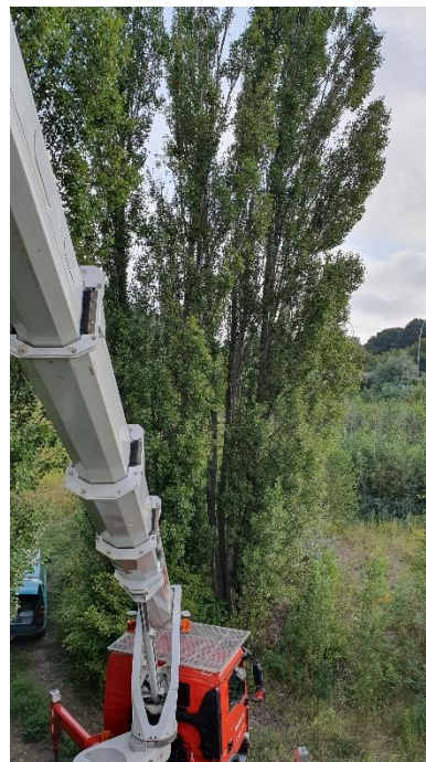
Abbildung 17: Kontrolle von Hebebühne aus
