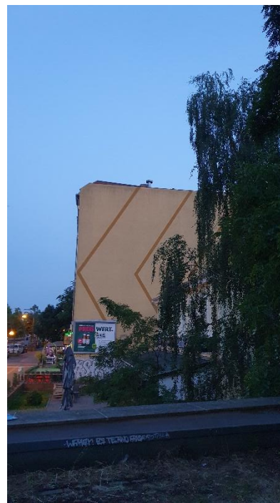
Abbildung 76: Zur Untersuchungsfläche zeigende Gebäudeseite
