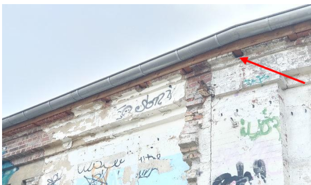
Abbildung 47: Öffnungen ins Gebäude im Dachbereich
