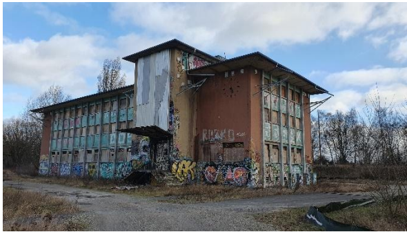
Abbildung 20: Ehemaliges Verwaltungsgebäude, Nordseite
