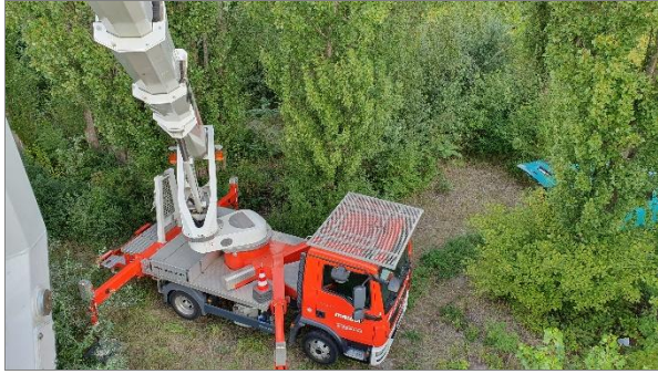
Abbildung 18: Kontrolle von Hebebühne aus
