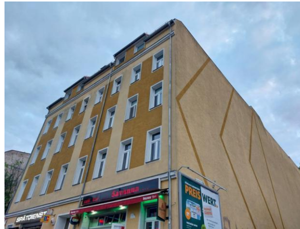
Abbildung 74: Straßenseite des Gebäudes
