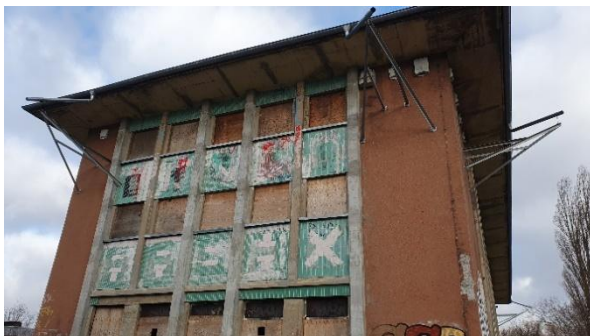
Abbildung 22: Westseite des Verwaltungsgebäudes
