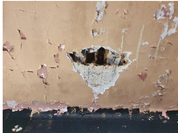
Abbildung 28: Löcher in Deckensteinen
