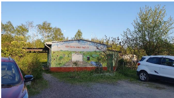
Abbildung 60: Standort 2: Vereinshaus der Kleingartenanlage
