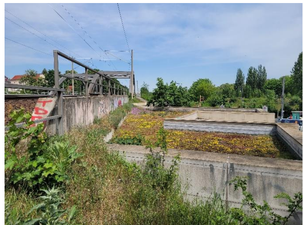
Abbildung 88: Teilfläche West, Gebäudeflachdächer
