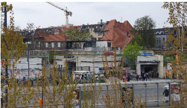
Abbildung 72: Standort 7: Gebäude der U-Bahnstation Pankow
