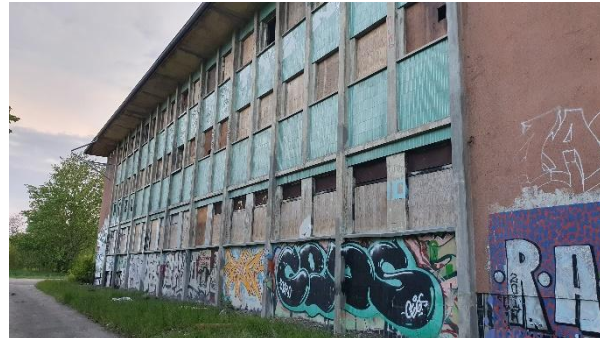
Abbildung 64: Südseite des Gebäudes
