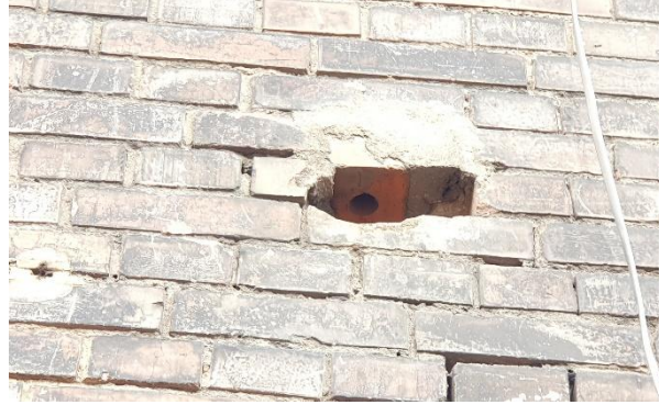
Abbildung 54: Offener Hohlblockstein im Mauerwerk
