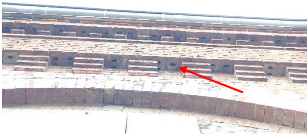
Abbildung 41: Hohlblocksteine im Dachbereich
