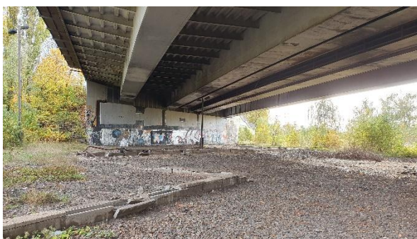
Abbildung 81: Brücke, Nistorte Bachstelze und Straßentaube
