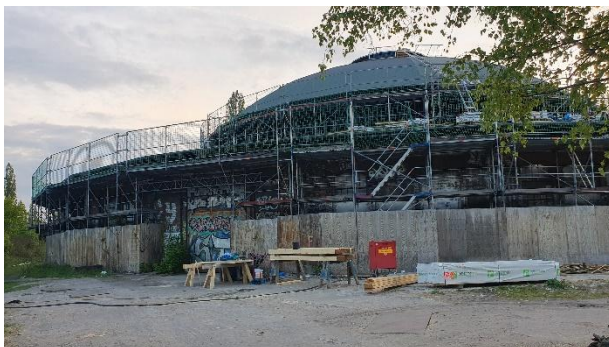
Abbildung 69: Eingerüsteter Rundlokschuppen an Standort 5
