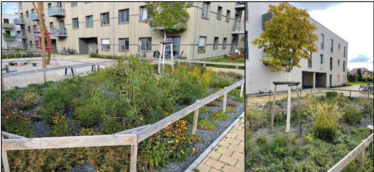
Abbildung 10: Beispiel für Mulden auf Privatgrundstücken, Wohngebiet Johannisgärten Berlin (Quelle: Ingenieurgesellschaft Prof. Dr. Sieker mbH 2022)
