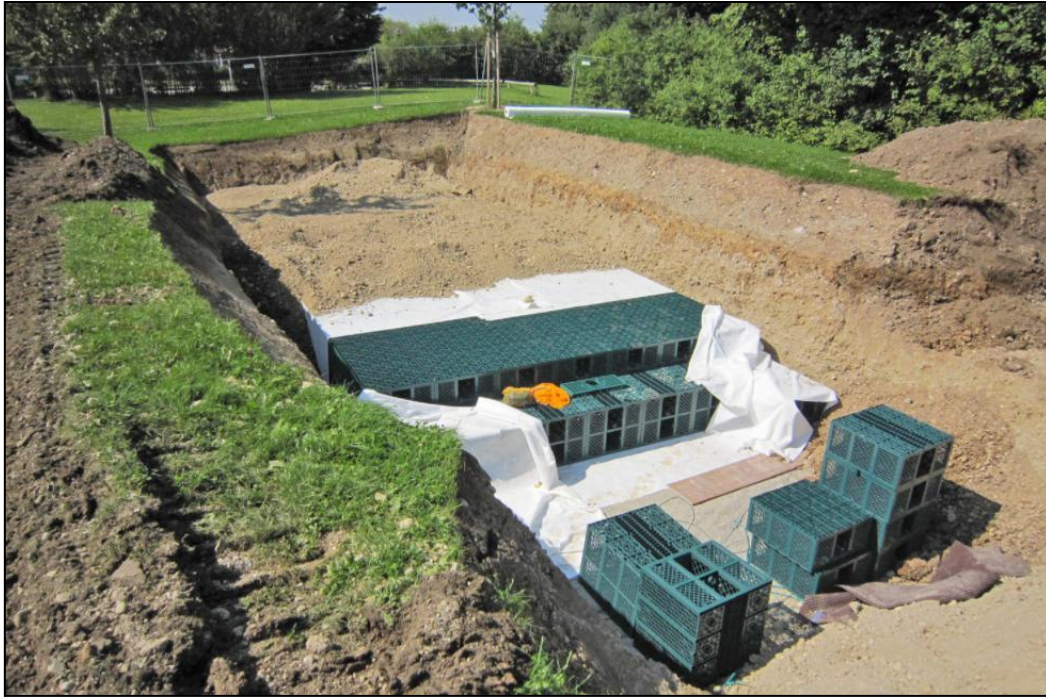
Abbildung 12: Ausführungsmöglichkeit einer Füllkörperrigole (Quelle: https://www.energiesystemtechnik.de/images/referenzen/aying-gs/aying-gs02.jpg/ , 22.01.2021)
