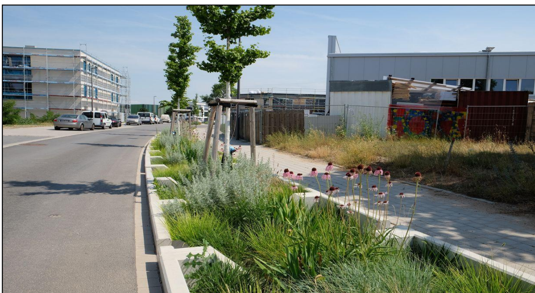
Abbildung 11: Tiefbeet-Elemente (Mannheim) (Quelle: Ingenieurgesellschaft Prof. Dr. Sieker mbH 2021)
