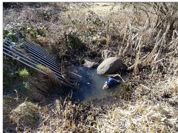
Abbildung 28: Geringe Wassermenge im Regenrückhaltebecken
