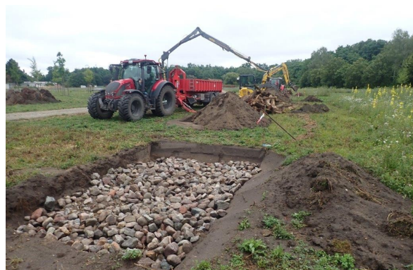
Abbildung 4: Beispielbild Aufbau Winterquartiere: Einbau Feldsteingemisch. Foto Christoph Bayer
