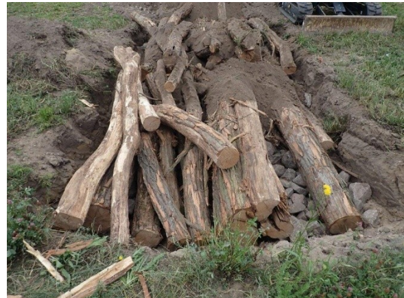
Abbildung 5: Beispielbild Aufbau Winterquartiere: Einbau Totholzstämmen. Foto Christoph Bayer
