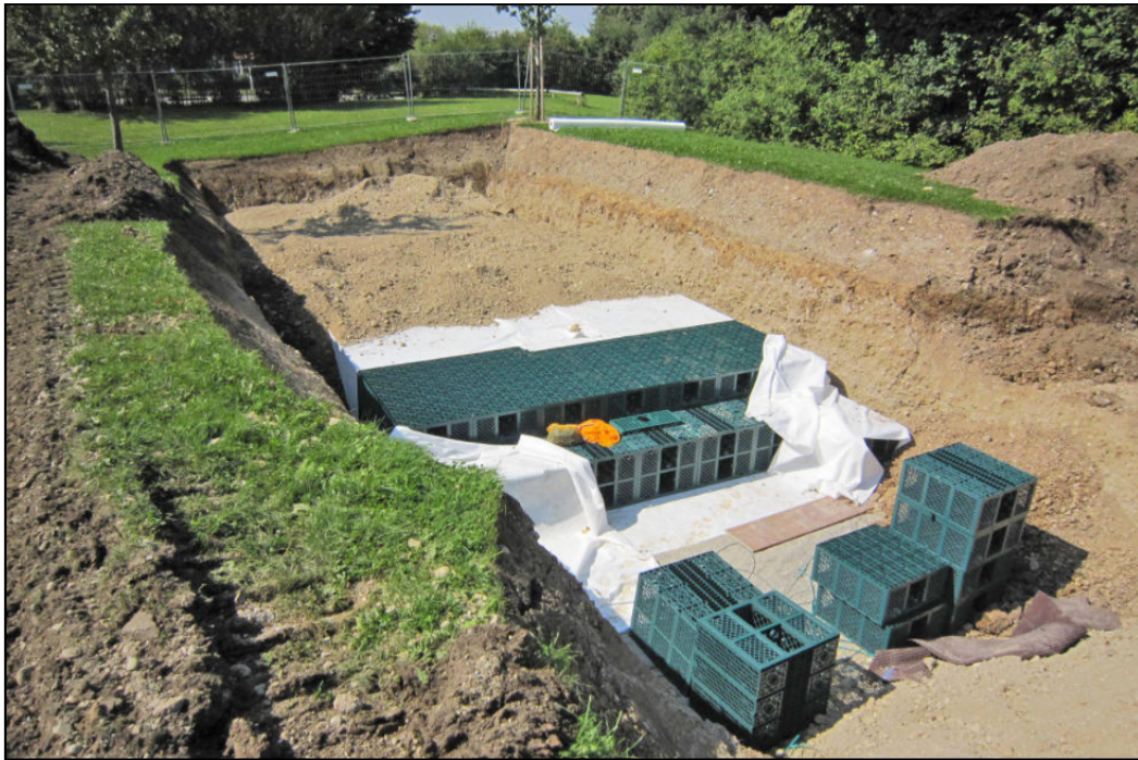
Abbildung 11: Ausführungsmöglichkeit einer Füllkörperrigole (Quelle: https://www.energiesystemtechnik.de/images/referenzen/aying-gs/aying-gs02.jpg/ , 22.01.2021)
