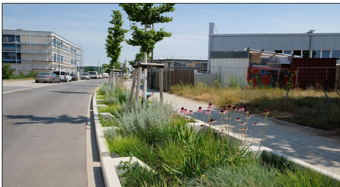
Abbildung 10: Tiefbeet-Elemente (Mannheim) (Quelle: Ingenieurgesellschaft Prof. Dr. Sieker mbH 2021)
