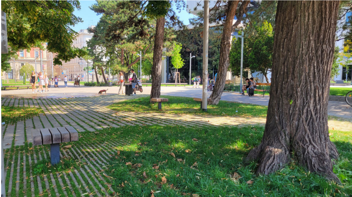
Abbildung 14: Beispiel einer wasserdurchlässigen Wege-/Platzbefestigung (Quelle: Ingenieuresellschaft Prof. Dr. Sieker mbH)
