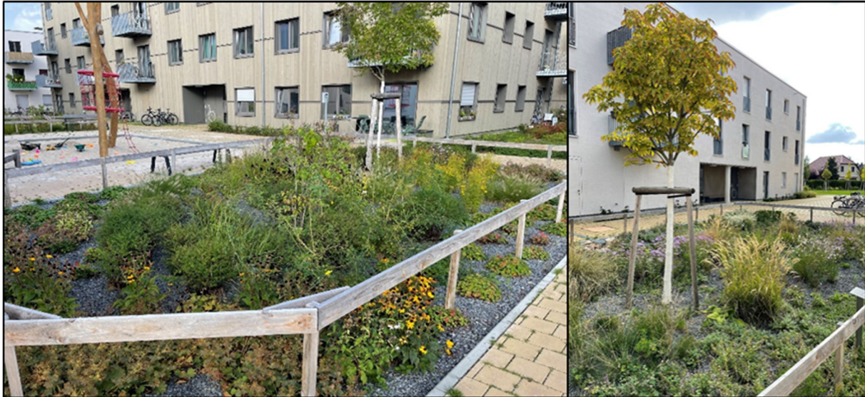
Abbildung 9: Beispiel für Mulden auf Privatgrundstücken, Wohngebiet Johannisgärten Berlin (Quelle: Ingenieurgesellschaft Prof. Dr. Sieker mbH 2022)
