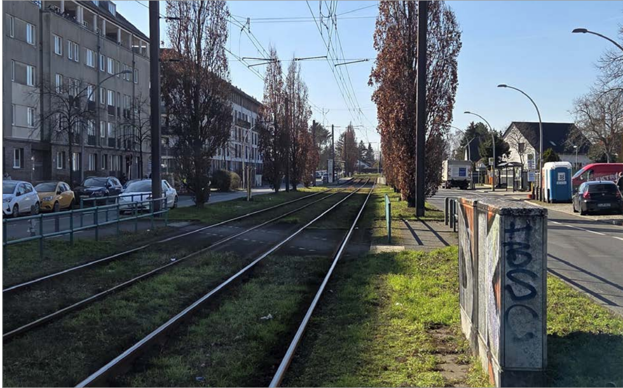
Abbildung 2-2 Fahrbahn der Straßenbahn im Rosenthaler Weg
