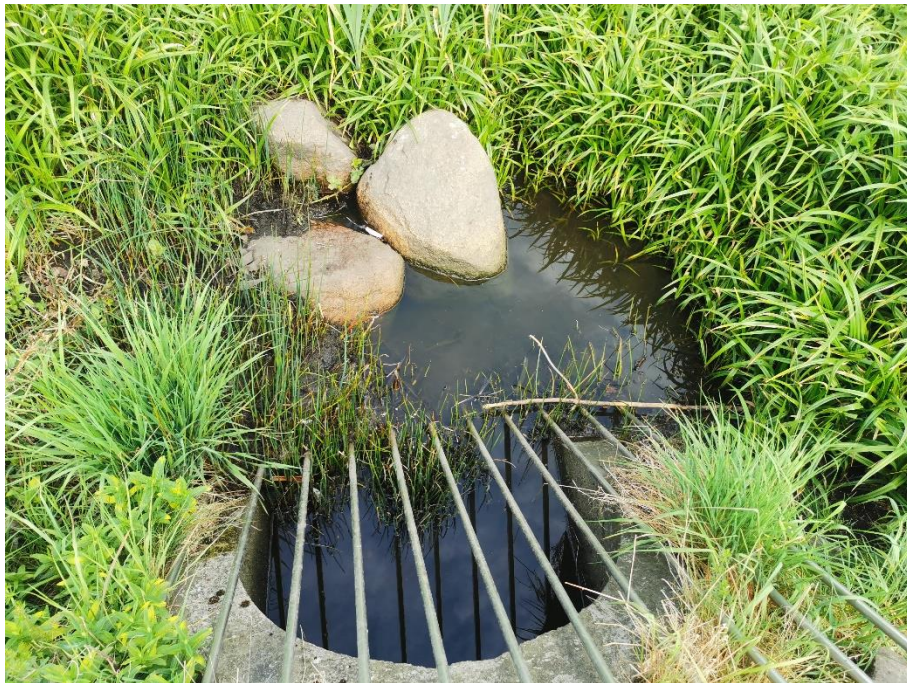
Abb. 4: Wasserstand des RHB am östlichen Zulauf (10.05.2024).
