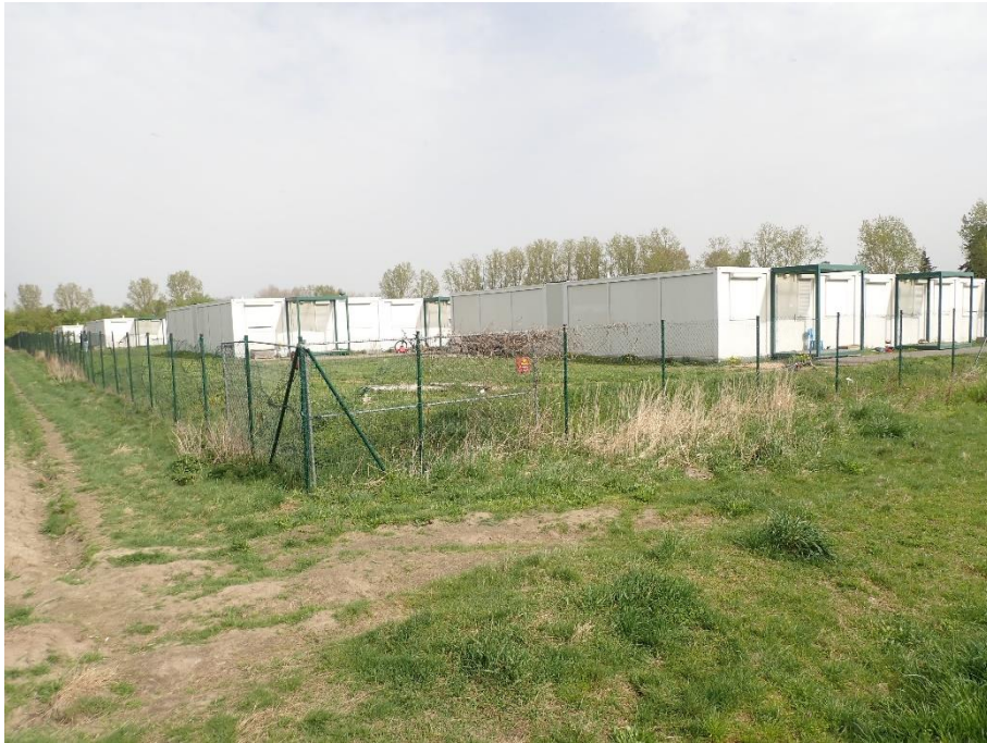
Abb. 5: Container-Unterkunft im Nordosten des UG (08.04.2024).
