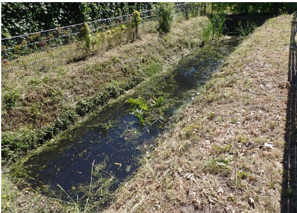
Abb. 3: Der Regenwasserrückhaltegraben am Kladower Damm nördlich des UG am 09.06.2024.
