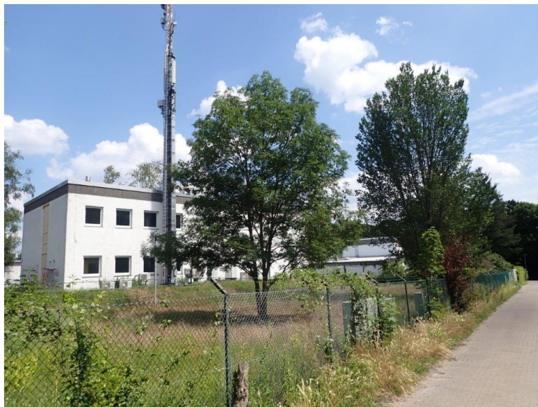
Das UG mit dem Umspannwerk Kladow im Hintergrund am 06.06.2024
