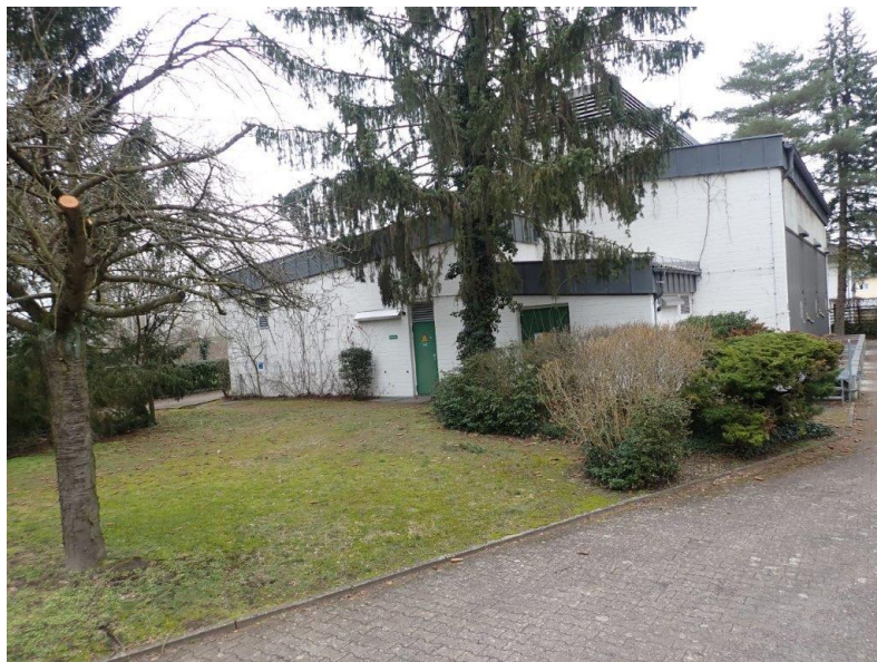
Das Umspannwerk Kladow am 26.02.2024
