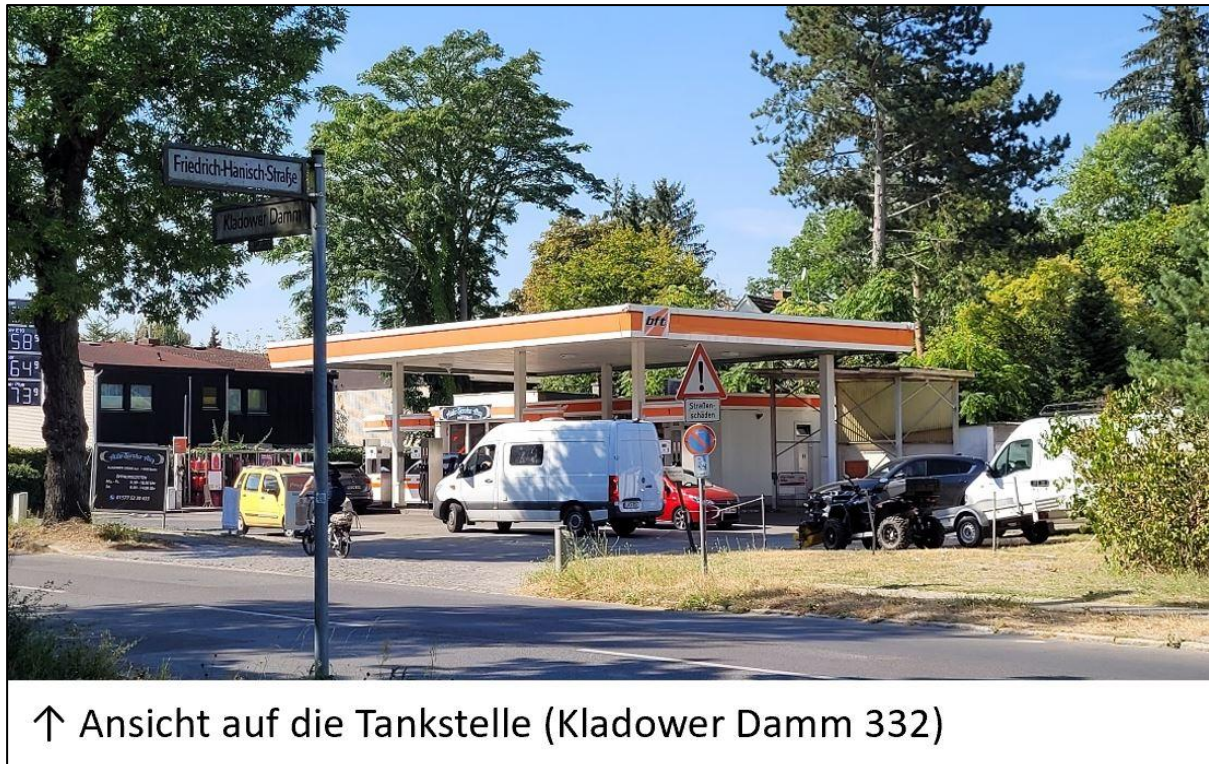
Abbildung 5: Foto der Tankstelle außerhalb des Plangebietes mit Beschreibungen der Lage /19/
