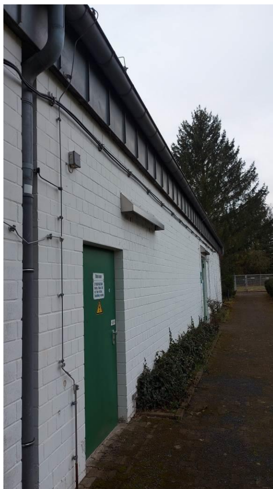
Abb. 8 Blick auf die nordwestliche Fassade des Umspannwerks
