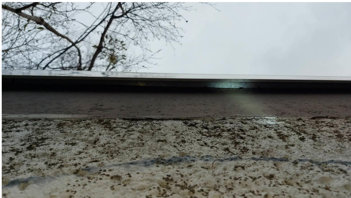
Abb. 6 Blick unter die umlaufende Blechkante des Kommunikationsgebäudes
