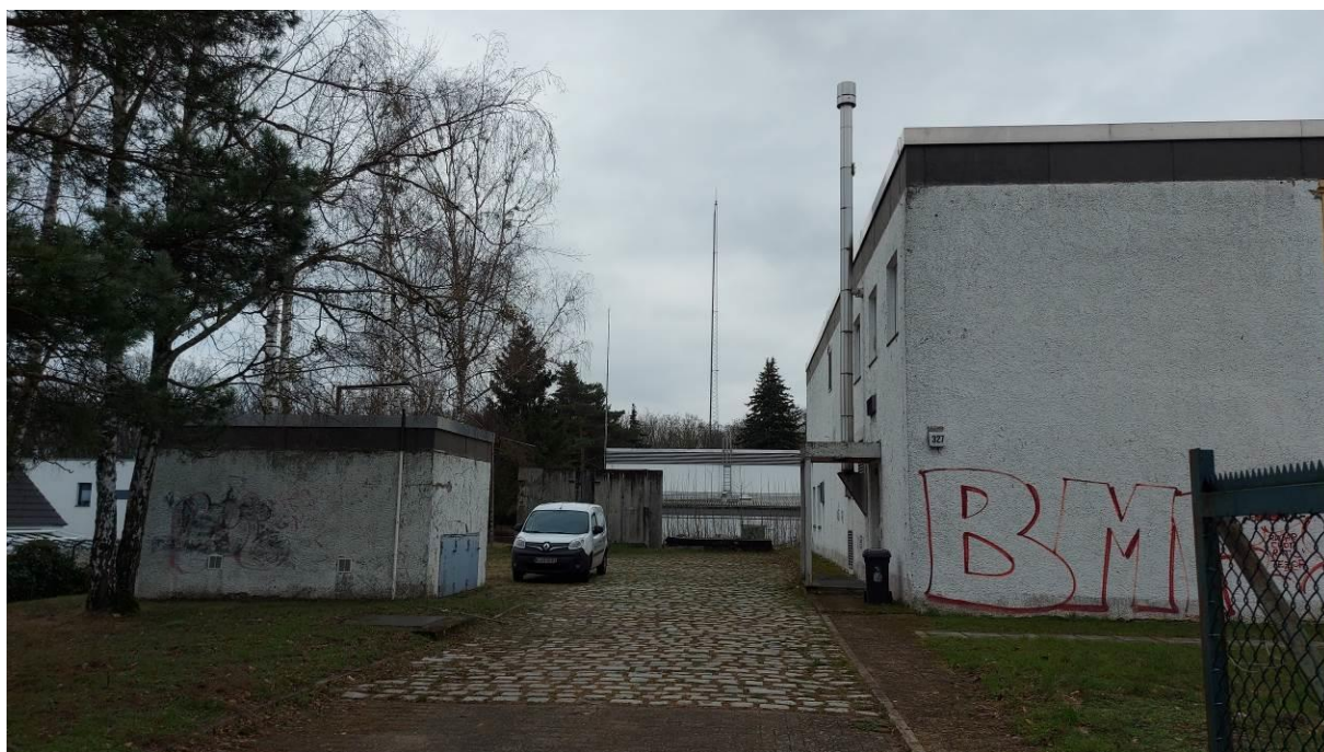
Abb. 5 Blick in Richtung Südost auf die Zufahrt des Grundstücks Kladower Damm 327 mit Nebengebäude (links) und Kommunikationsgebäude (rechts). Im Hintergrund das Umspannwerk
