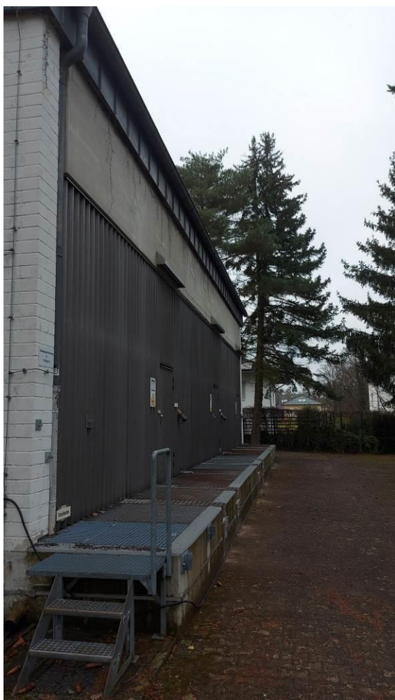
Abb. 7 Blick auf die südöstliche Fassade des Umspannwerks in der Friedrich-Hanisch-Straße
