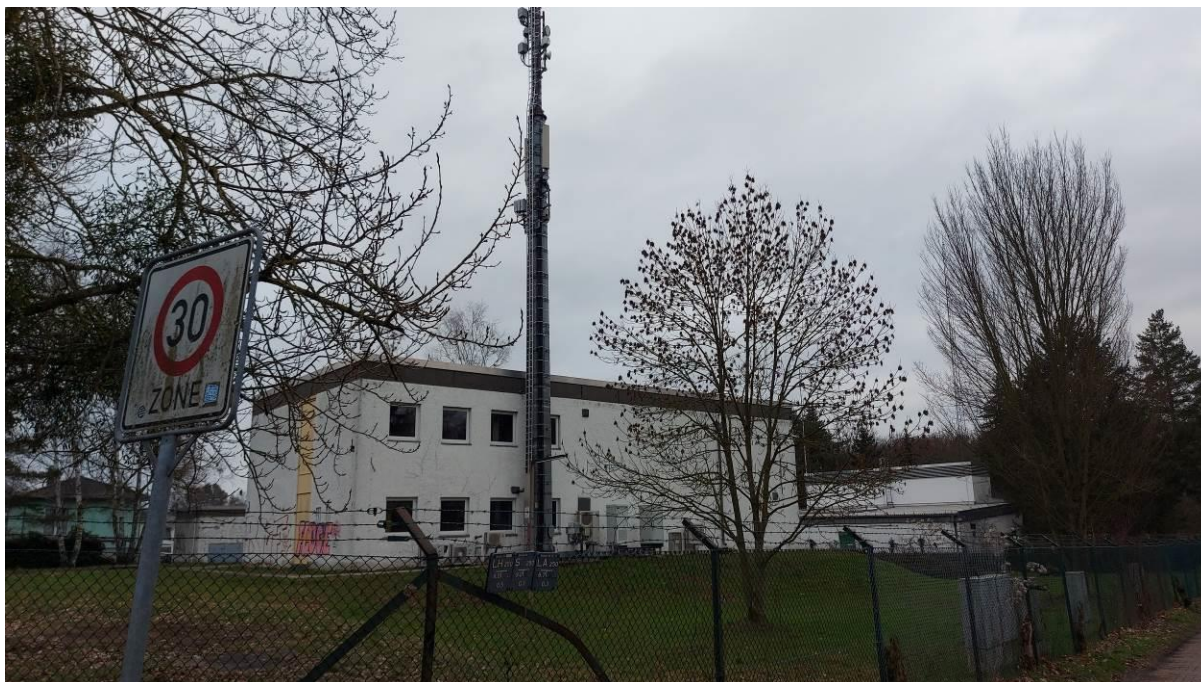
Abb. 4 Blick in Richtung Ost auf das Kommunikationsgebäude mit Mobilfunkmast auf dem Grundstück Kladower Damm 327 (Vordergrund). Im Hintergrund das Umspannwerk in der Friedrich-Hanisch-Straße 3
