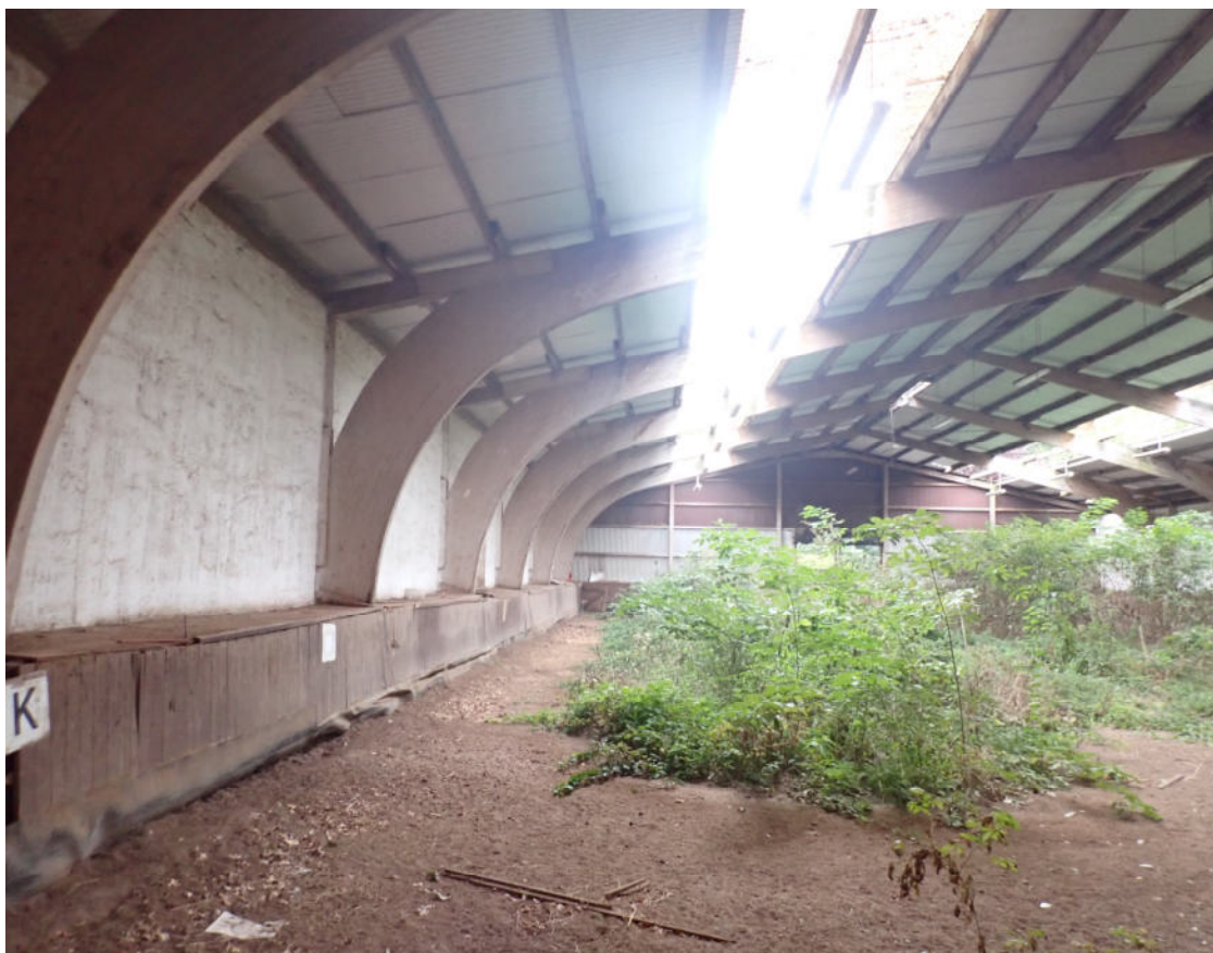
Abb. 7 Dachstuhl und Innenbereich Reithalle.
