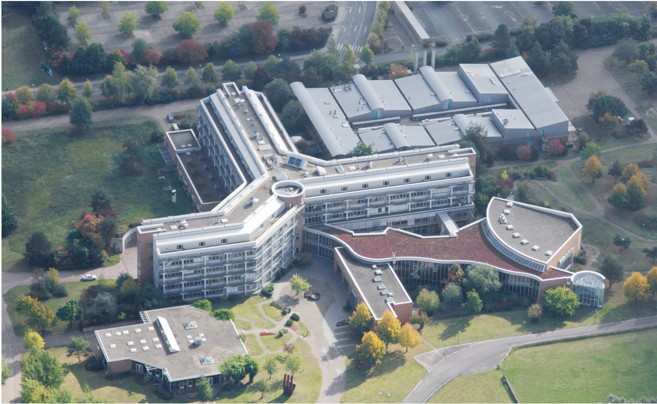
Luftbildaufnahme des Plangebiets (Foto: Bundesinstitut für Risikobewertung)
