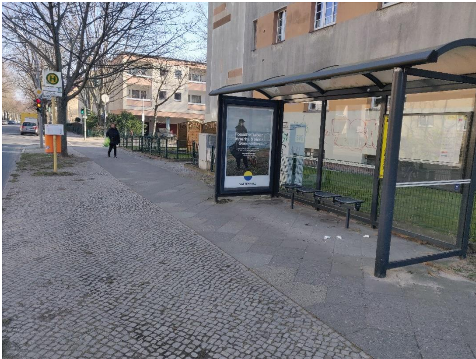
Abbildung 16: Eisenacher Straße, Bushaltestelle Kosleckweg Höhe Hausnr. 27a, Blick Richtung Osten
