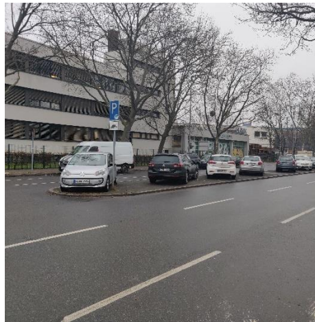
Südliche Fahrbahn in Fahrtrichtung von Westen nach Osten
