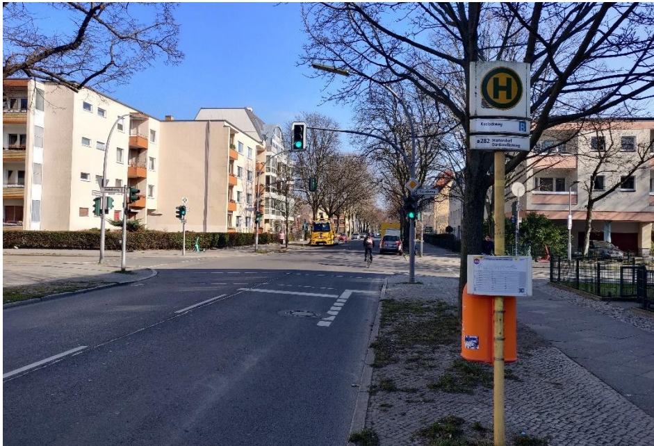
Abbildung 18: Knotenpunkt Eisenacher Straße / Steinhellenweg / Kosleckweg
