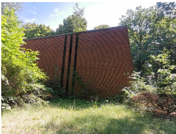
Abbildung 7: Ostfassade der Kapelle
