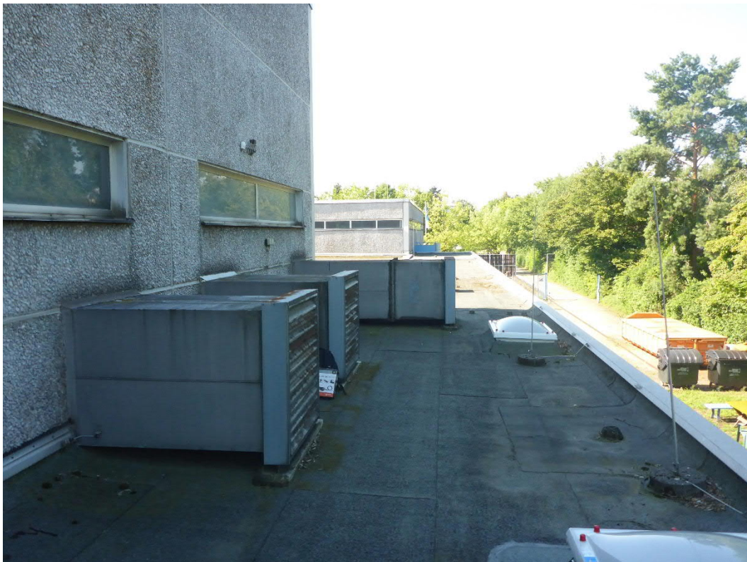
Abbildung 6: Abdeckungen auf dem Dach der Schwimmhalle
