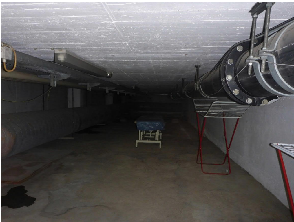
Abbildung 4: Kellerräume der Schwimmhalle
