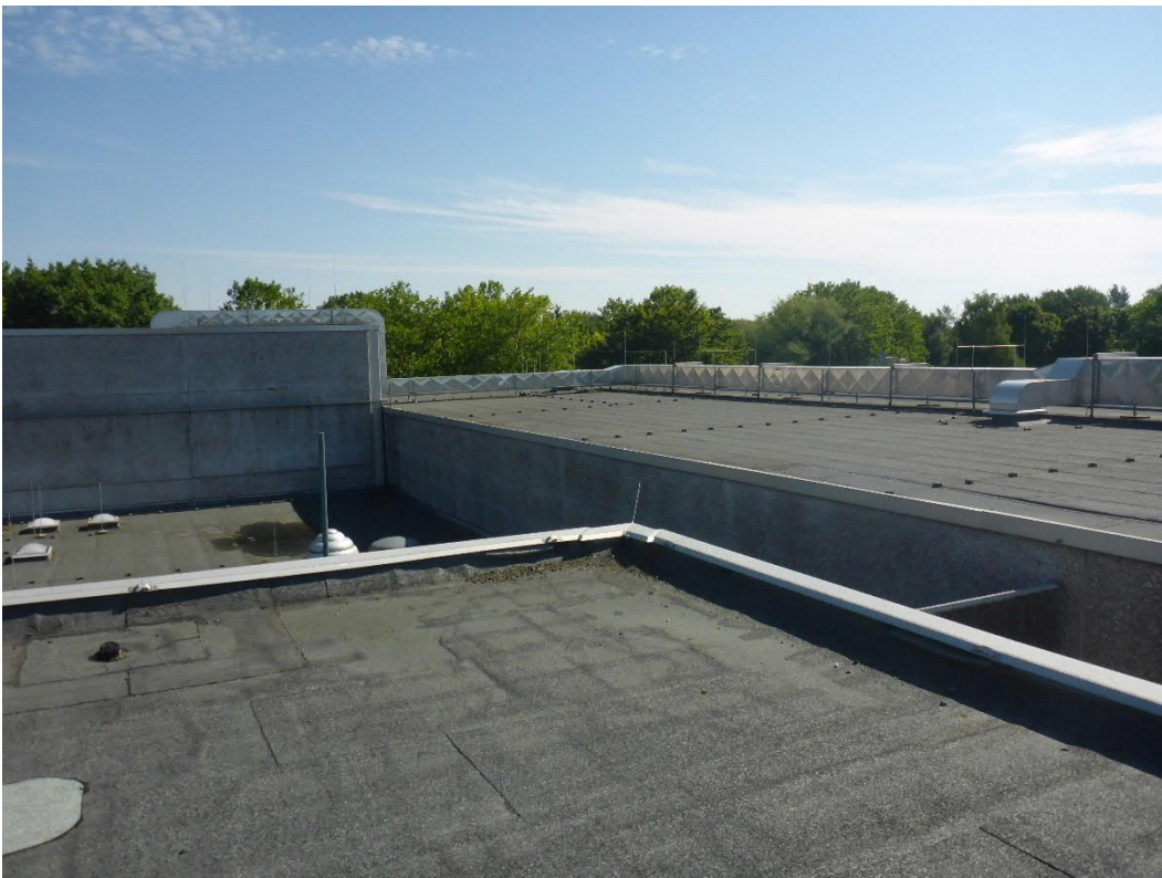
Abbildung 8: Dach der Schwimmhalle
