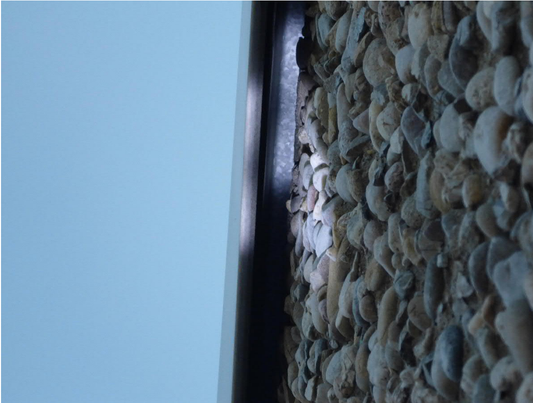
Abbildung 7: umlaufende Traufbleche am Dach
