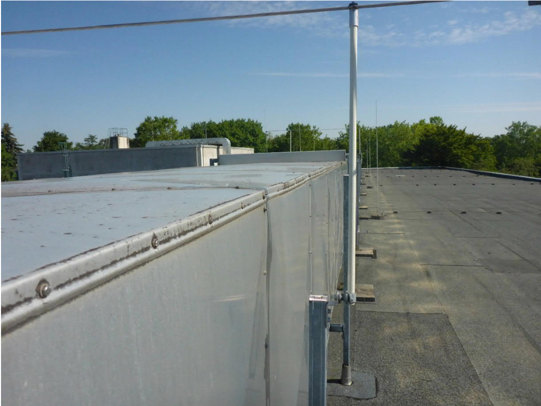
Abbildung 9: Dach der Schwimmhalle
