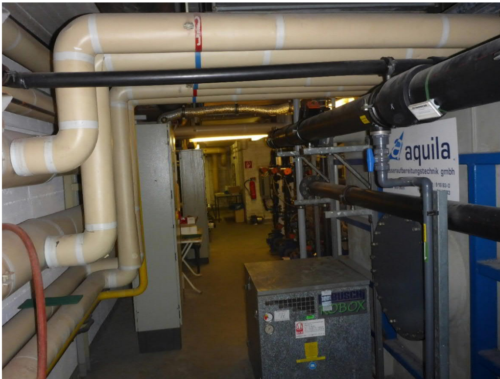
Abbildung 3: Kellerräume der Schwimmhalle
