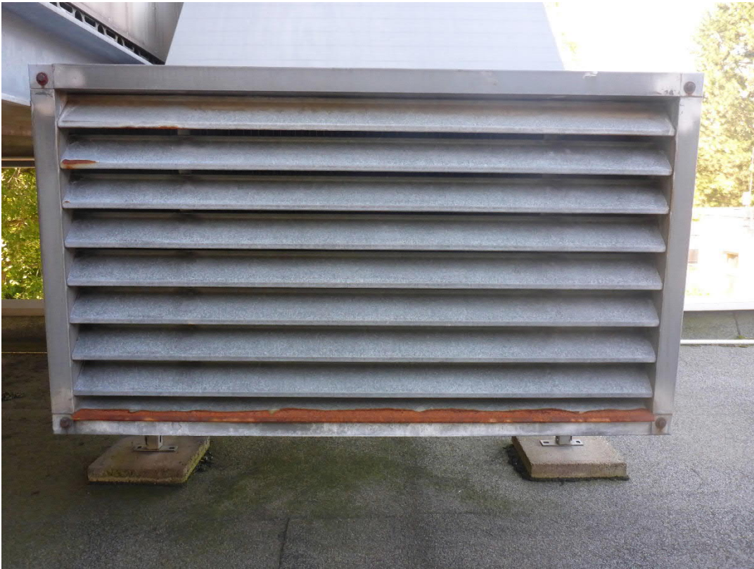
Abbildung 10: Detail vom Dach der Schwimmhalle
