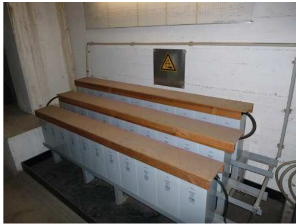
Abbildung 51: Galerie Notstrombatterien KG
