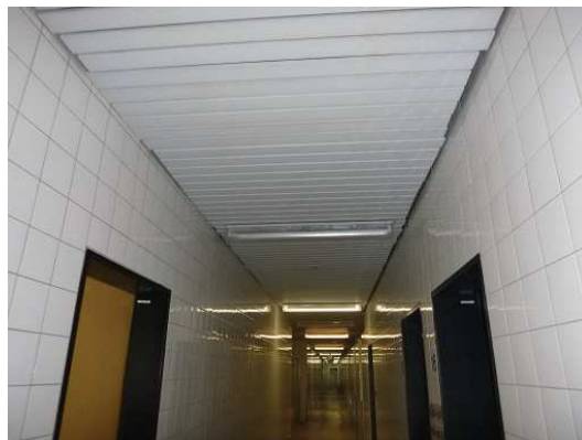
Abbildung 33: Ansichtsbsp. Alu-Lamellendecke Flur
