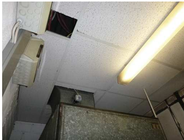
Abbildung 40: RD-Deckenplatten Technikraum 1.OG bei Sauna
