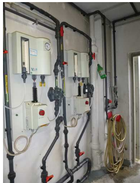
Abbildung 46: Regenfallrohr mit Revisionsklappe aus AZ, Chlorraum EG
