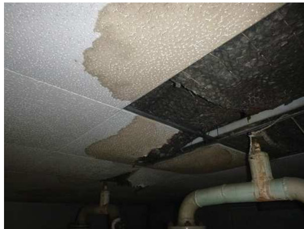
Abbildung 39: Ansicht RD-Platten mit MiWo-Dämmung Innendecke Technikzentrale 1.OG
