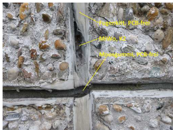
Abbildung 17: Ansicht Fugenkitt Außenfassade
