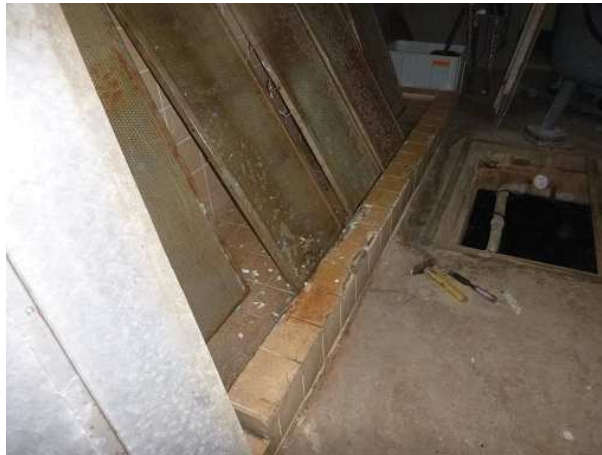
Abbildung 14: Fußbodenaufkantung mit XPS-Dämmung
