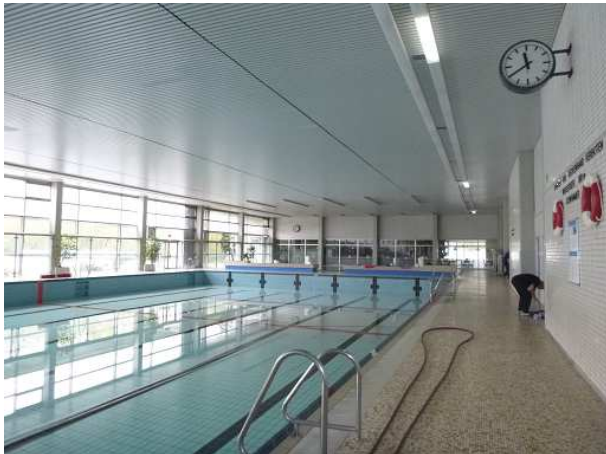
Abbildung 31: Hallendecke nach 2008 sanierter Bereich
