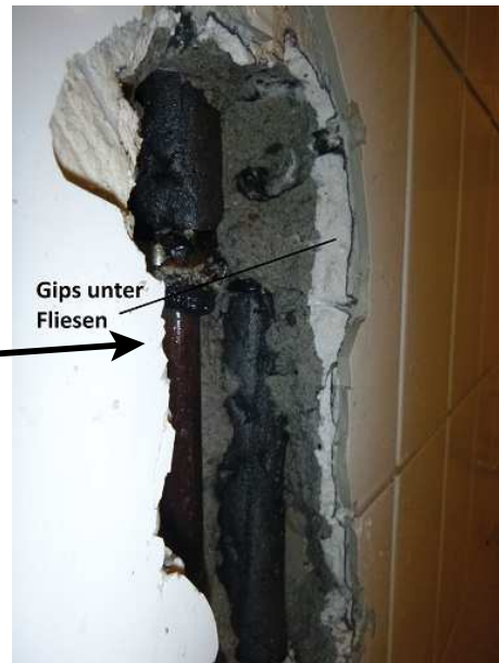
Abbildung 22: Detailaufnahme Wand-schichten Reparatur-stelle
