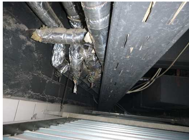
Abbildung 44: alu-kaschierte MiWo an RL Zwischen-decke Umkleidebereich EG
