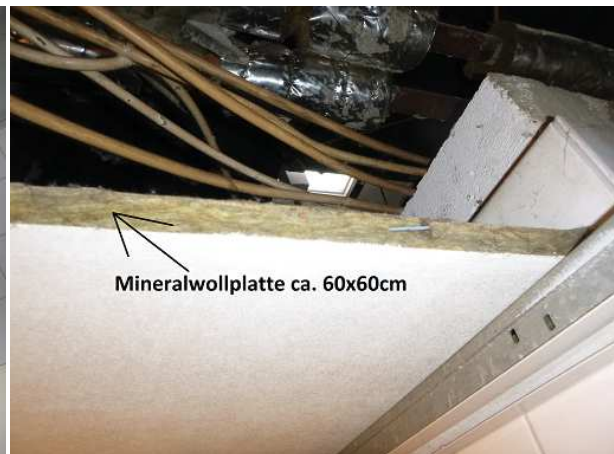
Abbildung 38: Detailansicht MiWo-Platten
