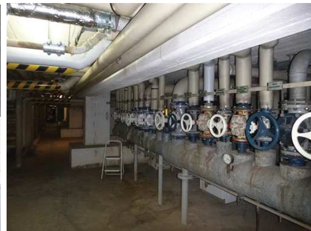
Abbildung 43: RL im KG; Alu-, Blech- und PE-Mäntel
