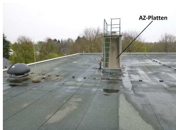
Abbildung 5: Ansicht Rauchabzug mit AZ-Platten
