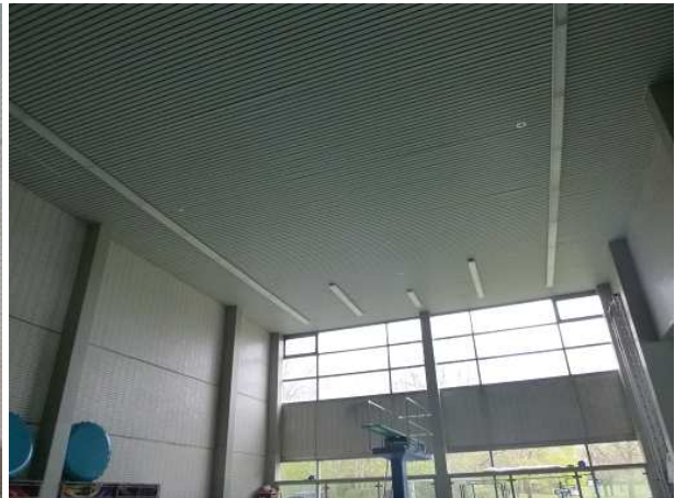
Abbildung 32: Innendecke am Sprungbecken
