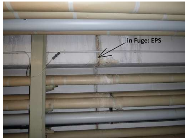
Abbildung 28: EPS-Fuge Schwimmbeckenwand KG
