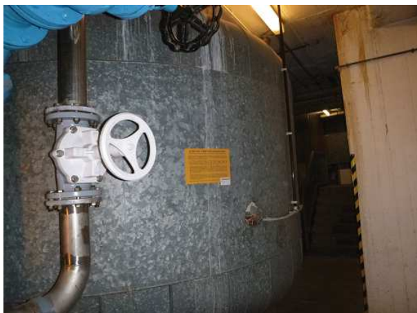
Abbildung 49: blechummantelter Wasserbehälter mit MiWo-Dämmung KG
