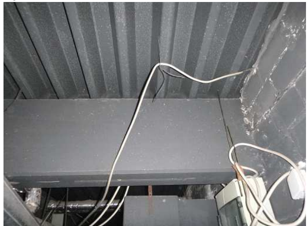
Abbildung 35: sichtbares Trapezblechdach im über Innendecken Flur Umkleidebereich
