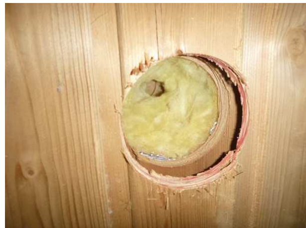
Abbildung 24: Bohrlochansicht Saunawand
