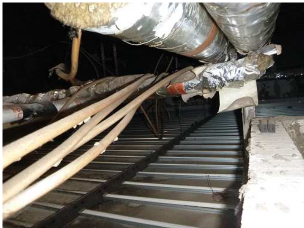
Abbildung 42: alu-kaschierte MiWo an RL Zwischen-decke Badleitung EG
