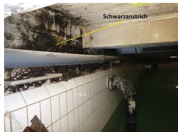
Abbildung 30: Beckenwand Schwallbecken KG
