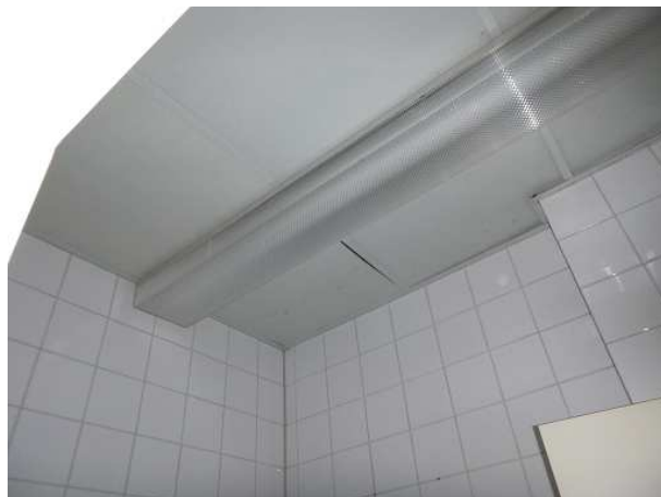
Abbildung 37: Deckenansicht Toilette Badleitung
