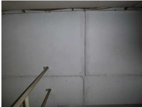
Abbildung 27: Beispielansicht Mörtelfugen zwischen Betonelementen Innenwand Technikzentrale 1.OG
