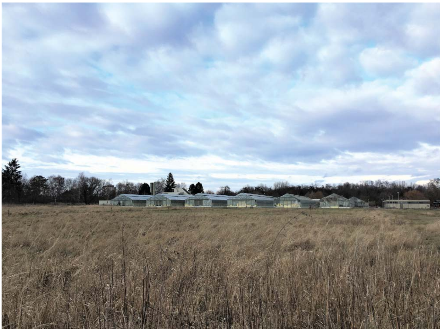
Blick in Richtung Norden auf die Gewächshäuser (Foto: BSM mbH)
