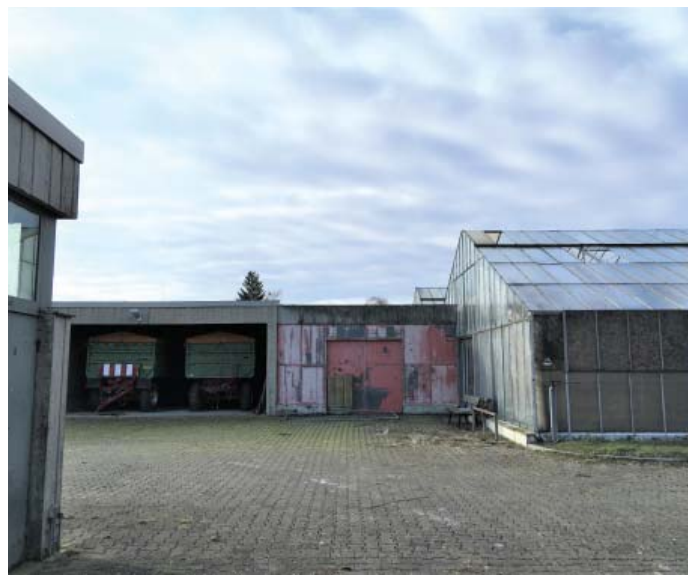
Wirtschaftsgebäude im Norden des Plangebiets (Foto: BSM mbH)
