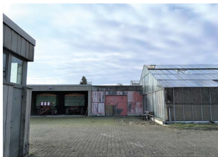
Wirtschaftsgebäude im Norden des Plangebiets (Foto: BSM mbH)
