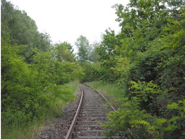
Abb. 13: Stillgelegte Bahnanlagen (OVGR ) im Süden des UG, mit Vorwald (WVMS).
