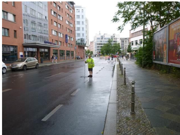
Abbildung 10: Feldarbeiten Höhenpunkt HP 2
