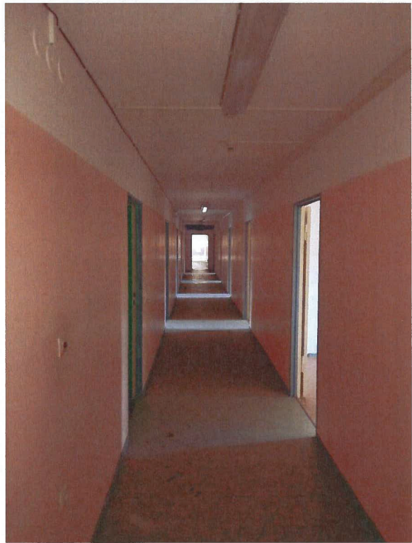
08.08.2022: Innenraum (exemplarisch für Gebäude 1-3)
