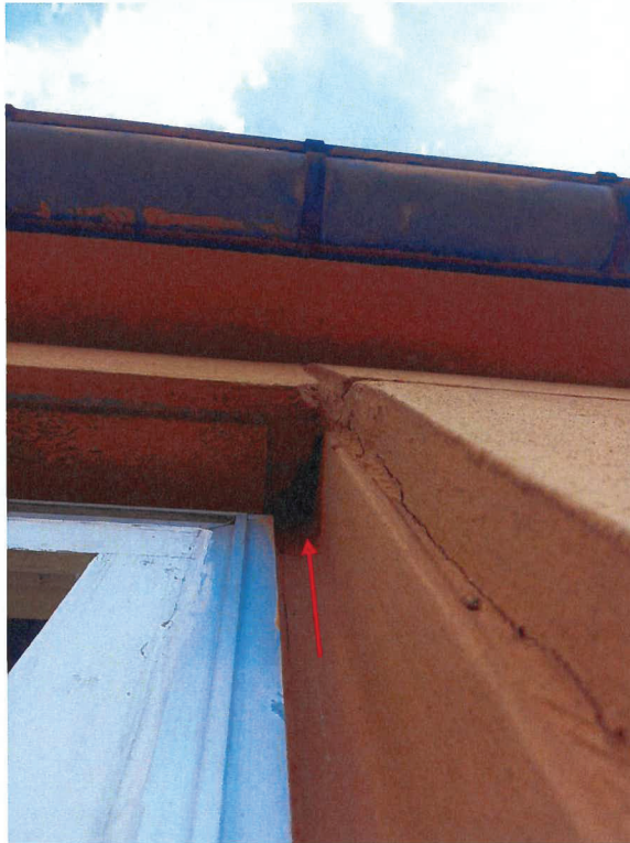
08.08.2022: Quartiersstruktur im Fensterbereich (exemplarisch für Gebäude 1-3)
