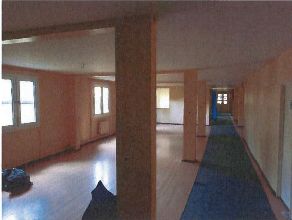
08.08.2022: Innenraum (exemplarisch für Gebäude 1-3)
