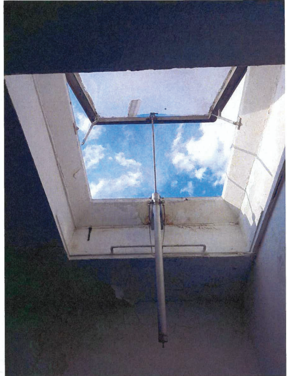
08.08.2022: offene Dachluke in Gebäude 1
