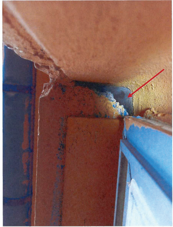
08.08.2022: Quartiersstruktur im Fensterbereich (exemplarisch für Gebäude 1-3)
