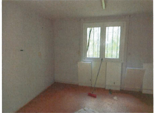
08.08.2022: Innenraum (exemplarisch für Gebäude 1-3)
