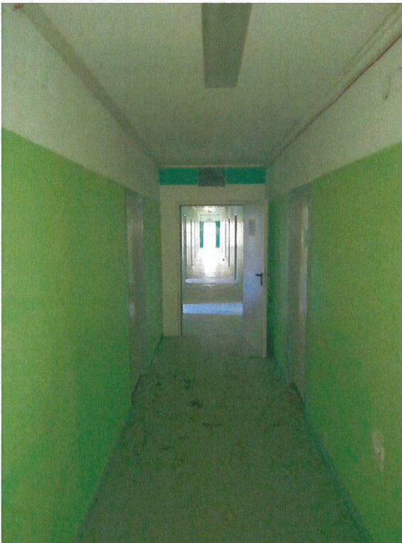
08.08.2022: Innenraum (exemplarisch für Gebäude 1-3)
