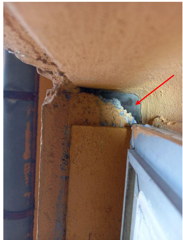
08.08.2022: Quartiersstruktur im Fensterbereich (exemplarisch für Gebäude 1-3)
