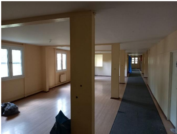
08.08.2022: Innenraum (exemplarisch für Gebäude 1-3)
