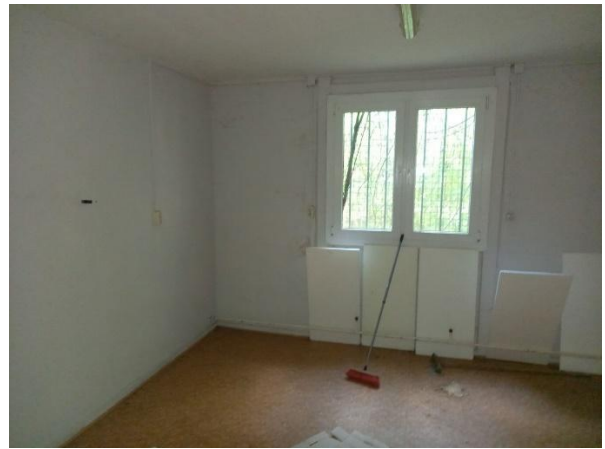
08.08.2022: Innenraum (exemplarisch für Gebäude 1-3)
