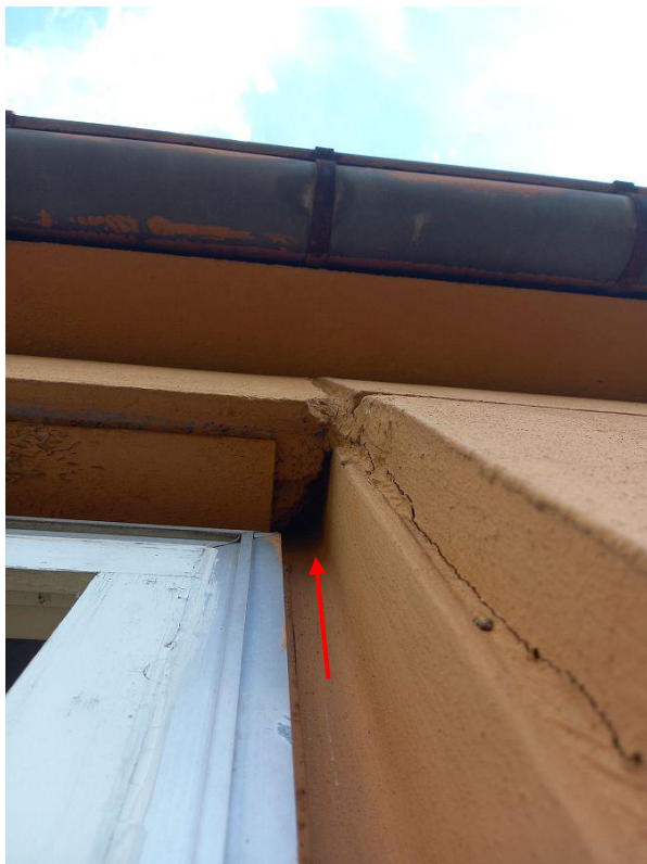
08.08.2022: Quartiersstruktur im Fensterbereich (exemplarisch für Gebäude 1-3)
