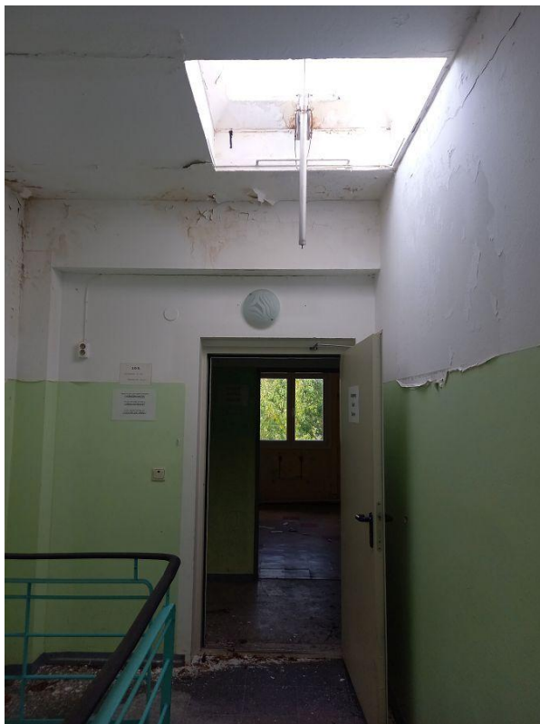
08.08.2022: offene Dachluke in Gebäude 1
