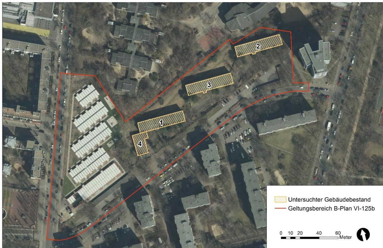
Abbildung 3: Lage der artenschutzrechtlich untersuchten Gebäude
