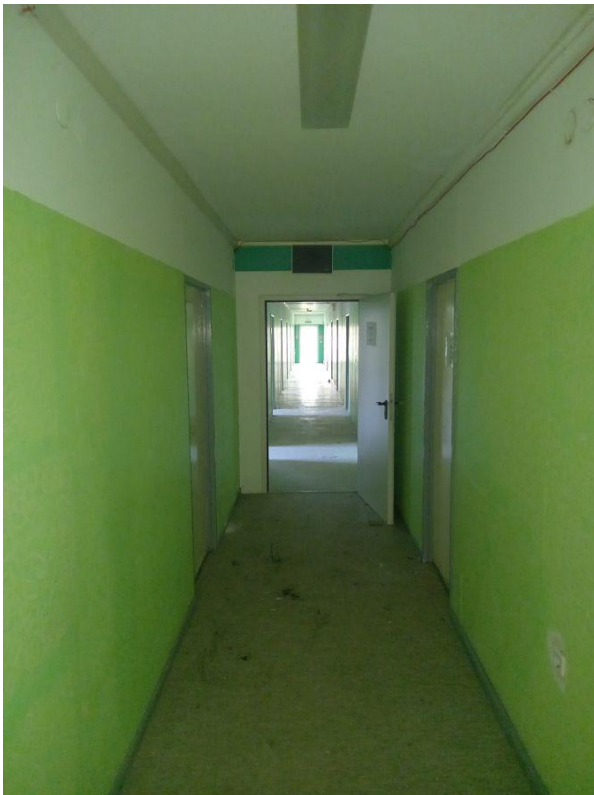
08.08.2022: Innenraum (exemplarisch für Gebäude 1-3)
