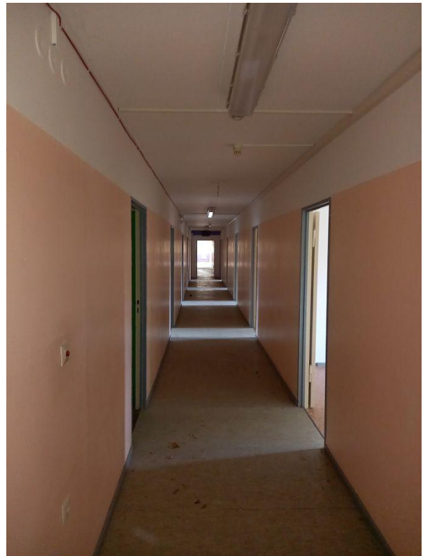
08.08.2022: Innenraum (exemplarisch für Gebäude 1-3)
