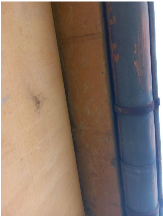
08.08.2022: potenzielle Quartiersstrukturen im Dachbereich
