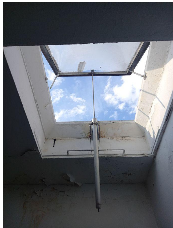
08.08.2022: offene Dachluke in Gebäude 1
