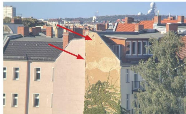
Abb. 15: Unverputzte Brandwand mit Nischen im offenen Mauerwerk
