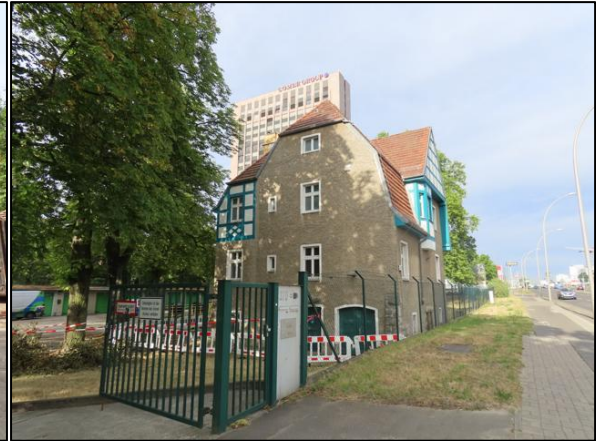
Abb. 16: Grundstück der Berliner Wasserbetriebe im Nordwesten des B-Plangebietes
