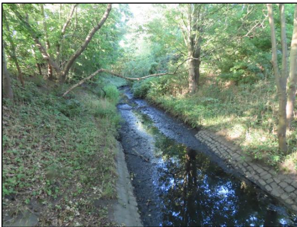
Abb. 11: Uferbefestigung des Marzahn-Hohenschönerhauser-Grenzgrabens
