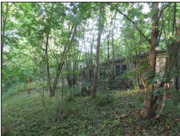
Abb. 19: Ruinöse Gebäude im westlichen Bereich des B-Plangebietes
