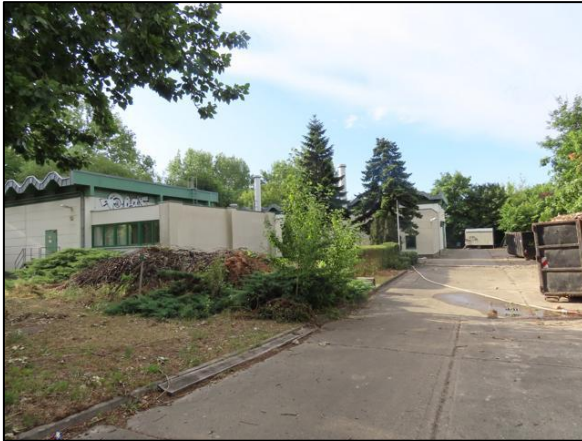
Abb. 15: Grundstück der Berliner Wasserbetriebe im Nordwesten des B-Plangebietes
