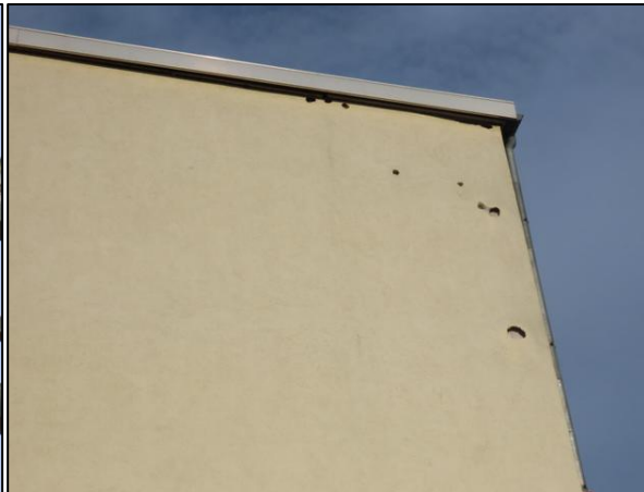
Abb. 42: Brutplatz von Staren in Spechtlöchern in einem Wärmedämmverbundsystem auf dem IPH-Gelände
